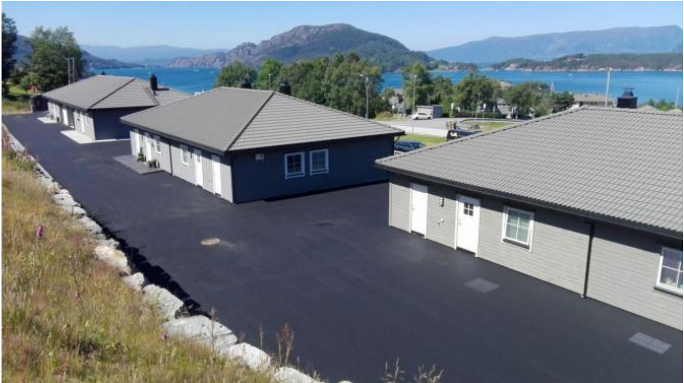
Asfalteringa gjeld heile 5000 kvadratmeter. Det omfattar alle vegar og private tun.
