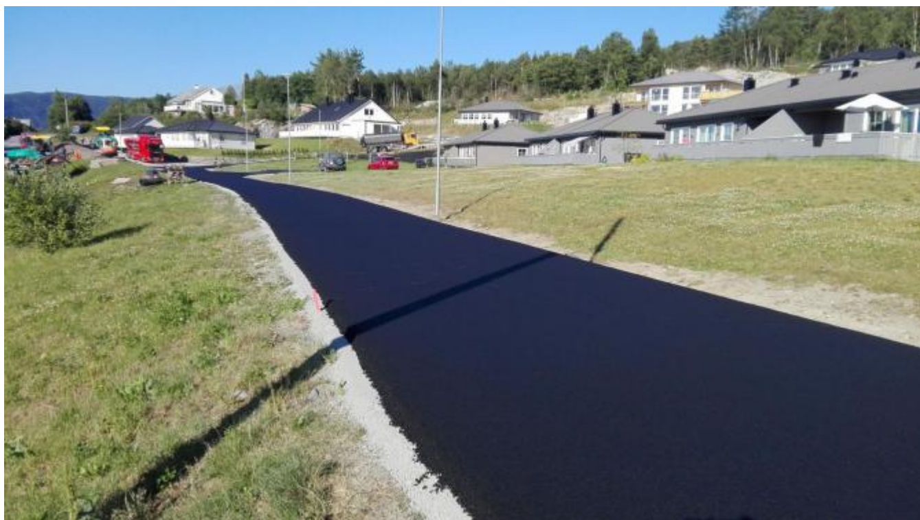
Kvinnherad Asfalt har arbeidet med asfalteringa i Ospelunden.
