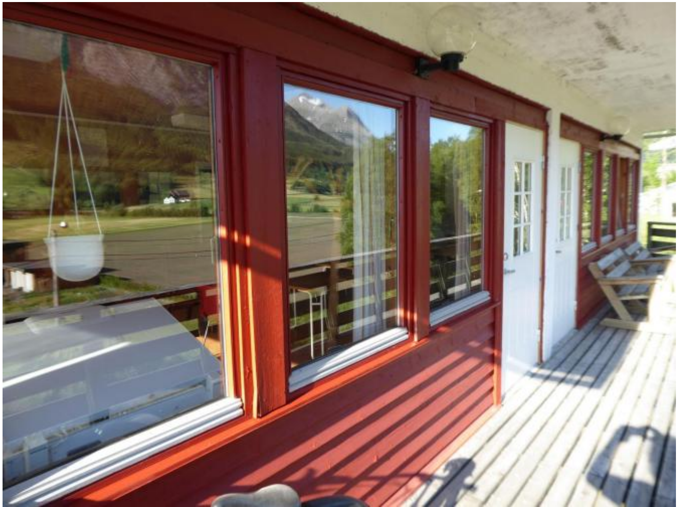
Audun Eik i styret har skrappt, pussa og målt veggene på scenebygget.
