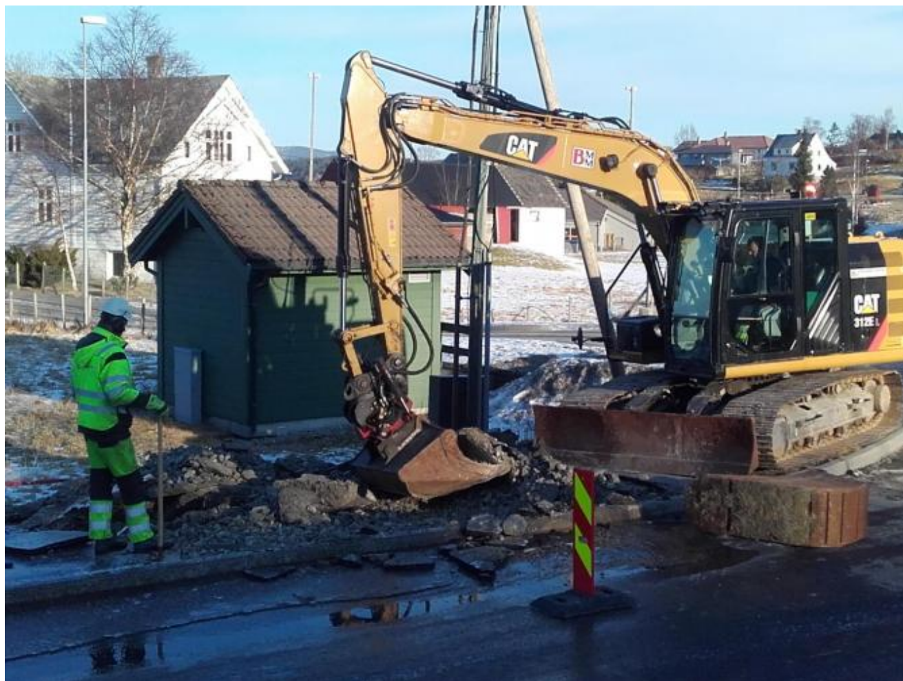
Eit vassbrot langs Fylkesvegen vert ofte ei omfattande og kostbar sak. Vassbrotet ved busslomma for kort tid sidan hadde ein kostnad på vel kr. 200.000,-
