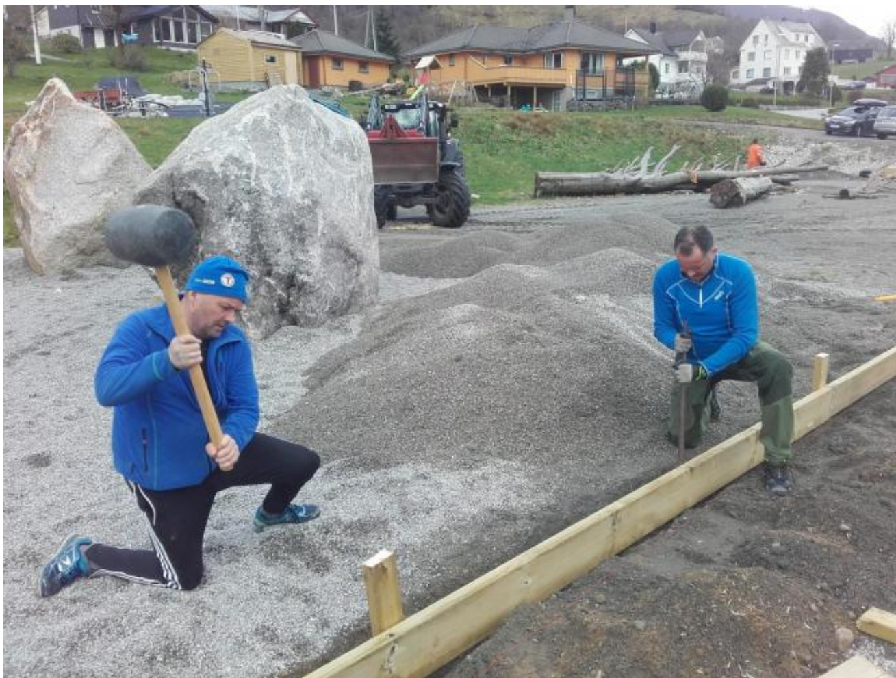
Dugnadsgjengen gjer klar klatreparken med kantlist og fallunderlag.
