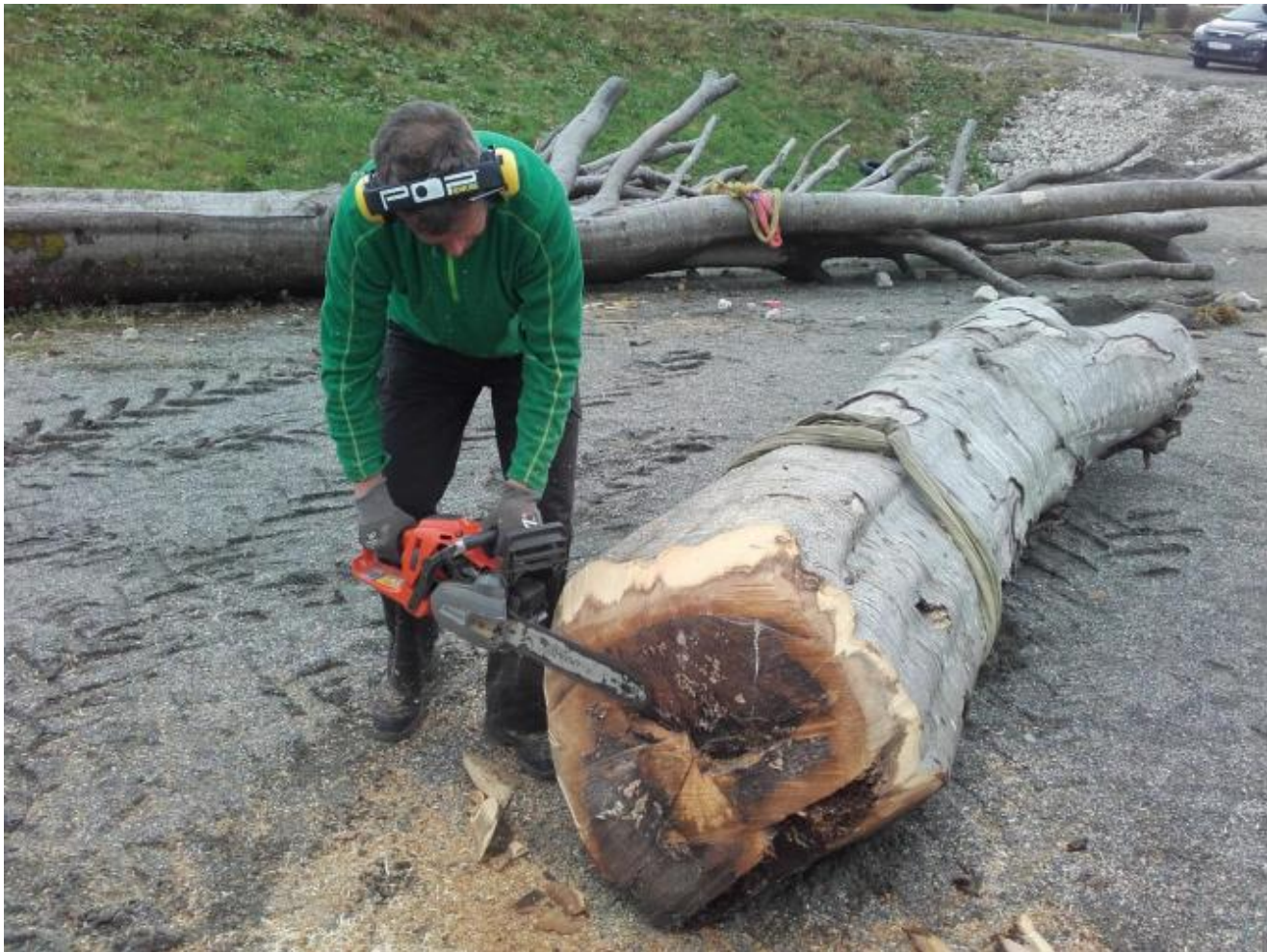
Fundamentet til bøkeklatrestativet vert runda og pussa i kantane for å unngå skade.
