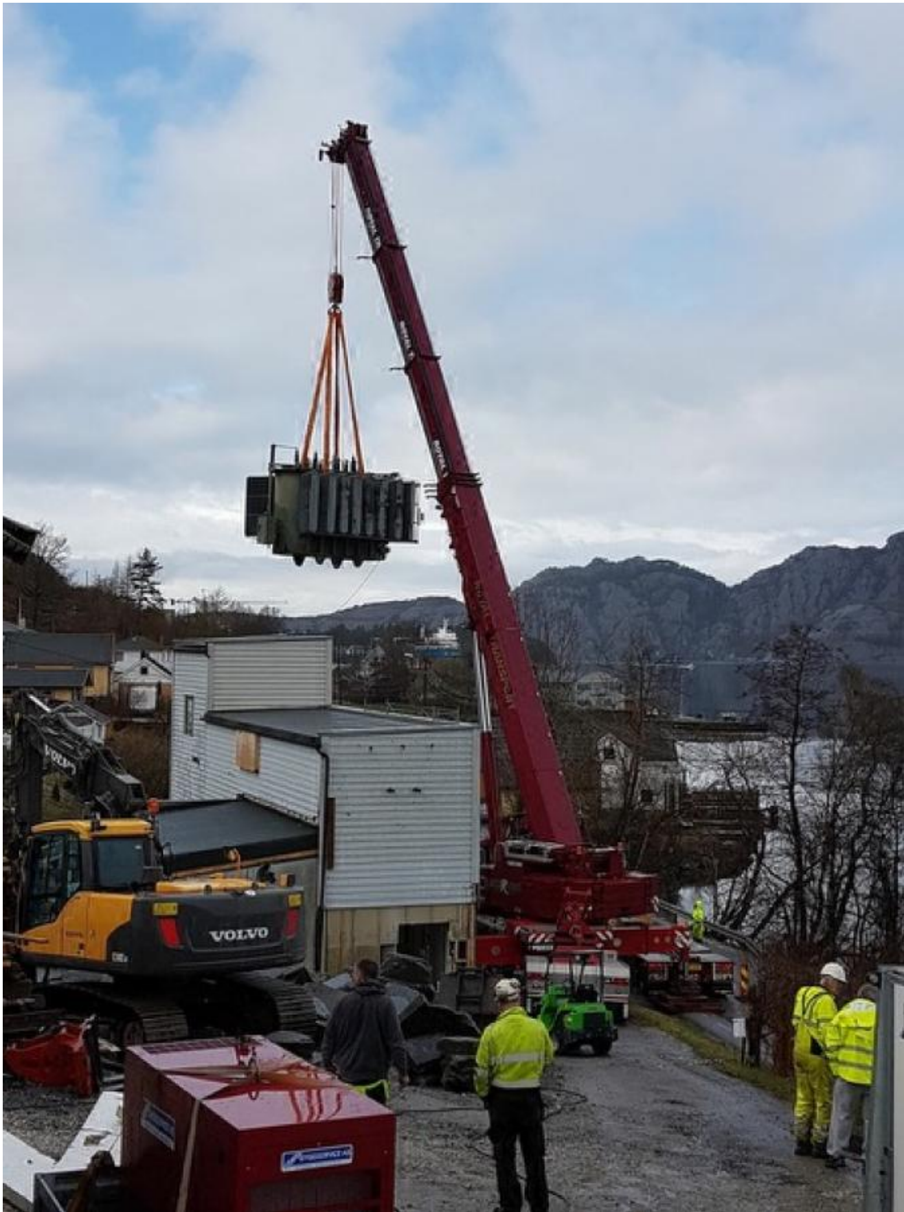
Det var eit tungt løft då den gamle trafoen frå 1971 på 42 tonn vart løfta ut av Sekundærstasjonen i Uskedalen. Bilete syner at det er stor byggeaktivitet med betongarbeid, muring, ny kledning og monteringsarbeid.
