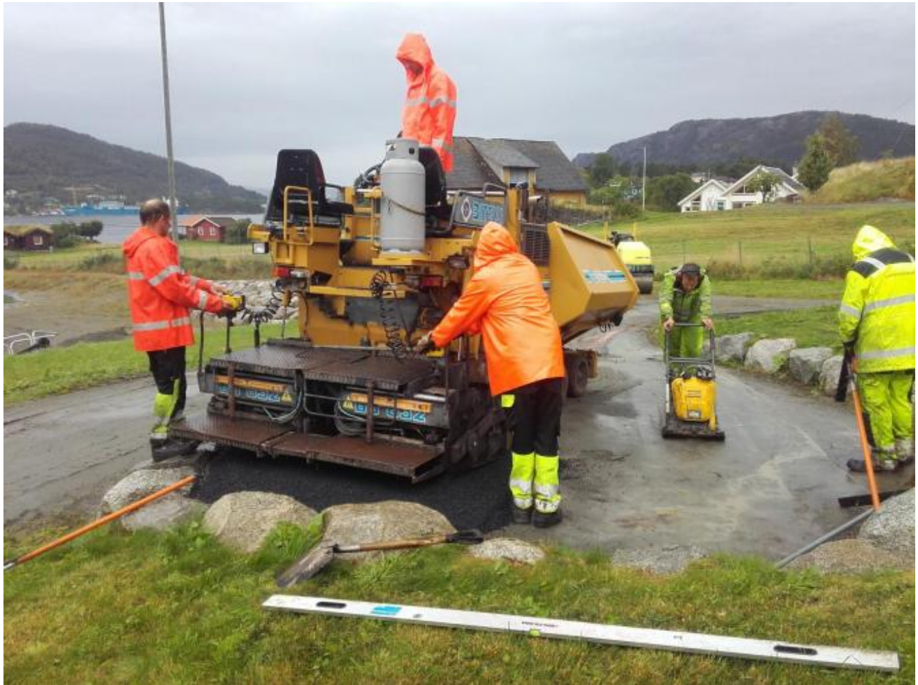
Gangvegane og rasteplassane vert avretta og asfalterte.
