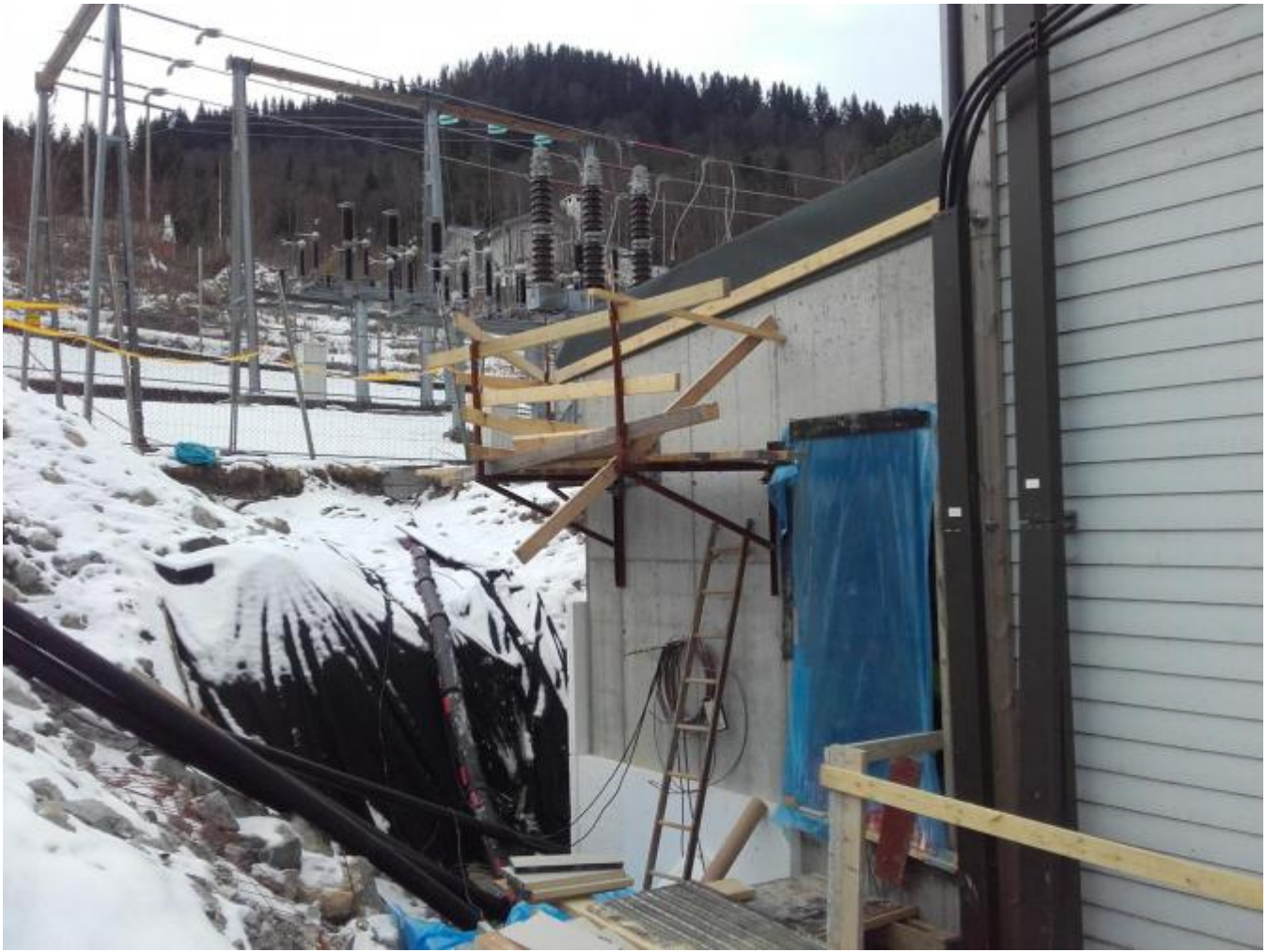
Stasjonen vert utvida i bakkant og alt elektrisk utstyr vert fornya.
