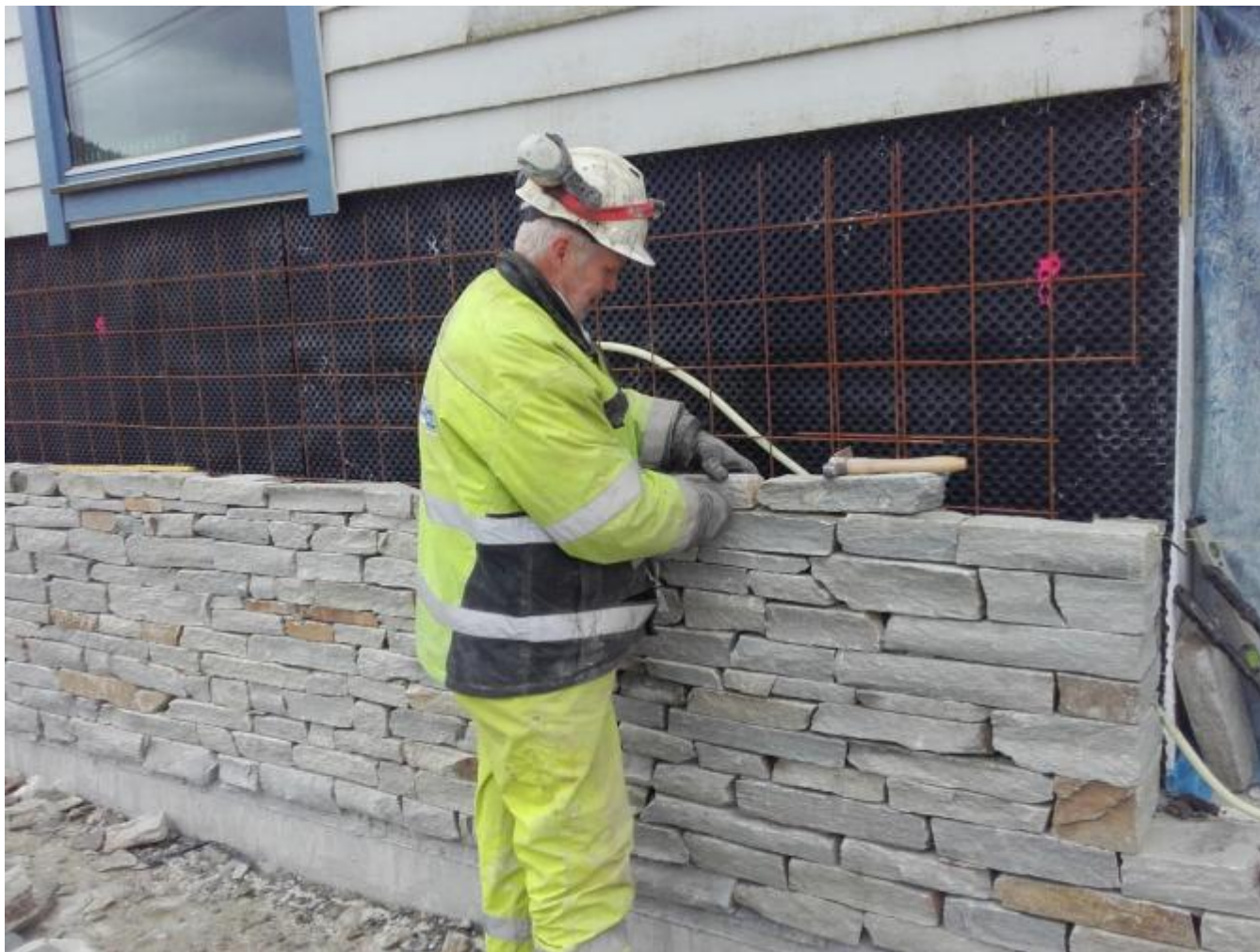
Fasaden vert ny med flott mur i framkant. Muraren er Knut Magnar Tveito i Byggservice.
