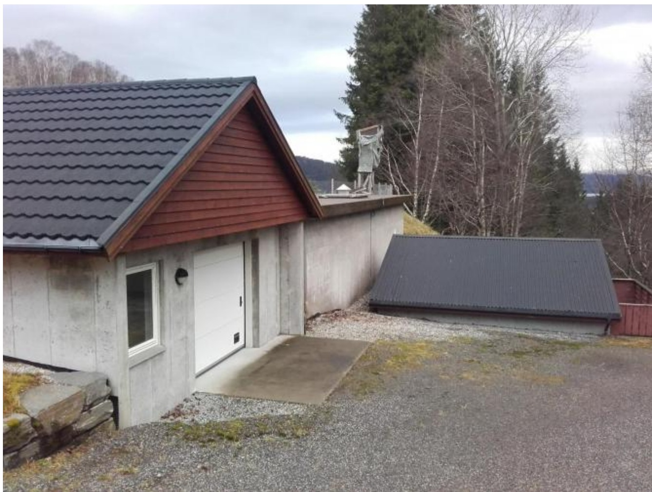
Uskedal Vassverk sitt vassbehandlingsanlegg på Eik.
