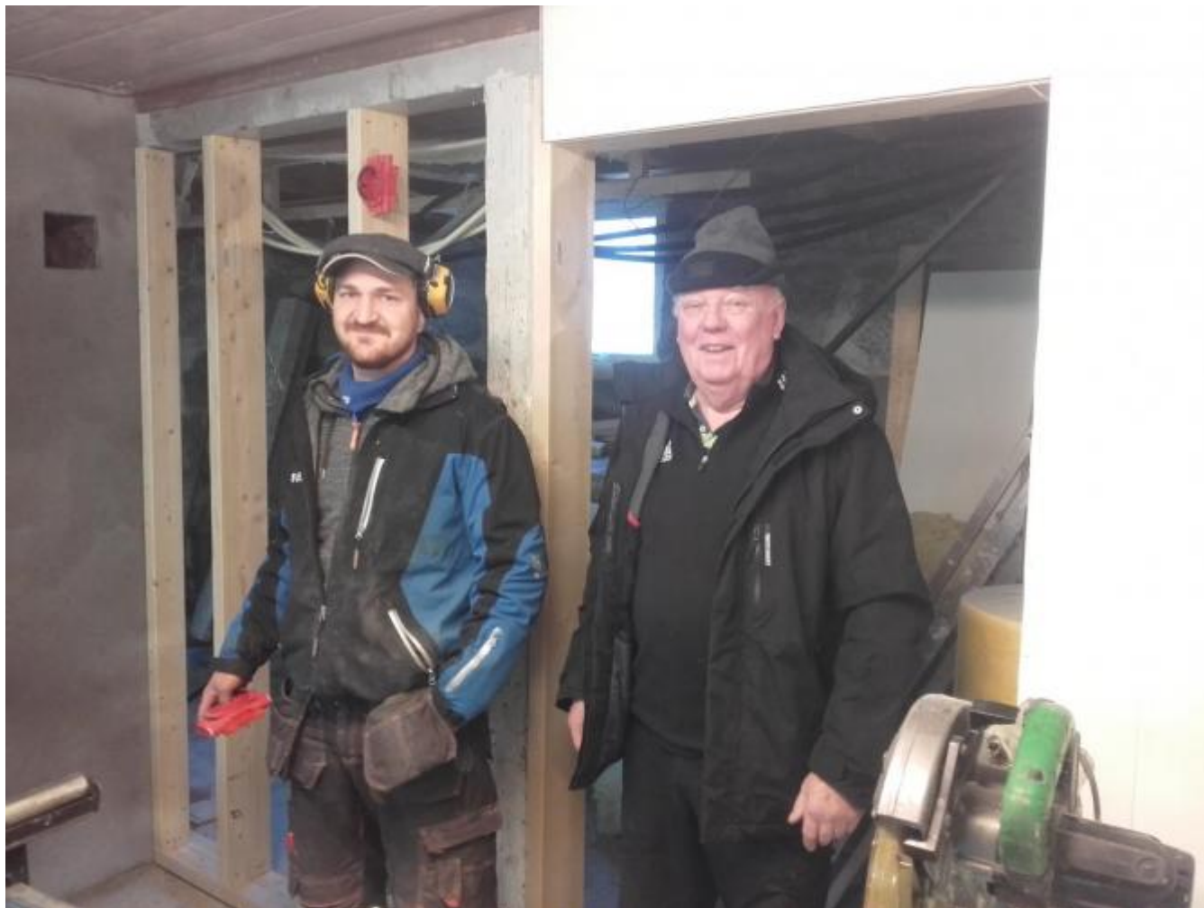
Det vert gjort klart for ytre avdeling av fire mindre rom i kjellaren, teknisk rom, to toalett og lagerrom. F.v: Johannes Hegland og Jan Erik Olsson.
