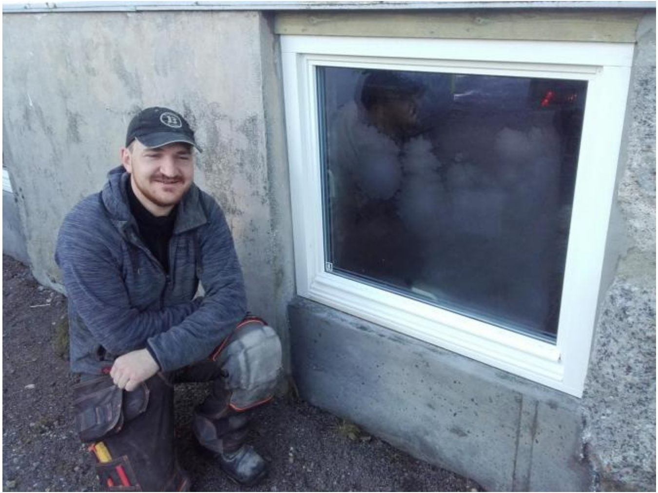
Johannes Hegland frå Helgand Bygg og anlegg har skifta alle vindaugo i kjellaren.
