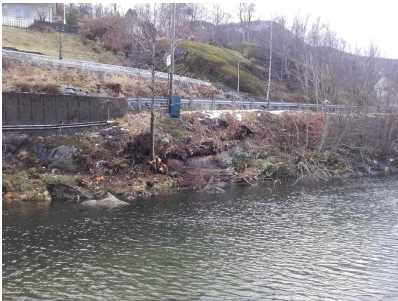
Almås sitt areale ved brua vert rydda. Det er eit krevjande arbeid i den bratte skråningen.
