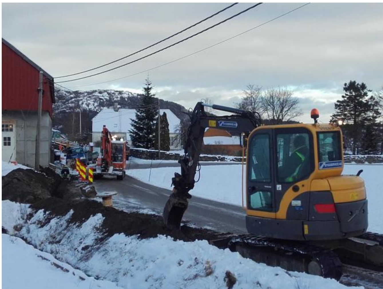
Blanke ledningar skal bort og vert erstatta med nytt kabelanlegg på Nedre Fet.
