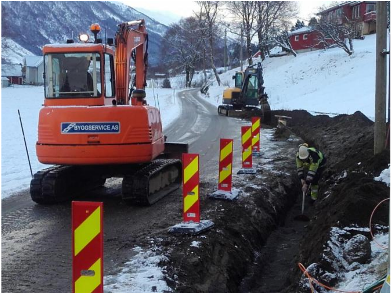
Georg Hestad frå Kvinnherad Energi ser til at kabelen vert lagt forsvarleg i dertil eigna sand.
