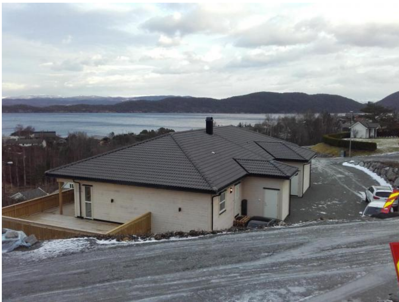
Ein tremanns bustad i byggefeltet Ospelinden vart ferdigstillt i 2017.
