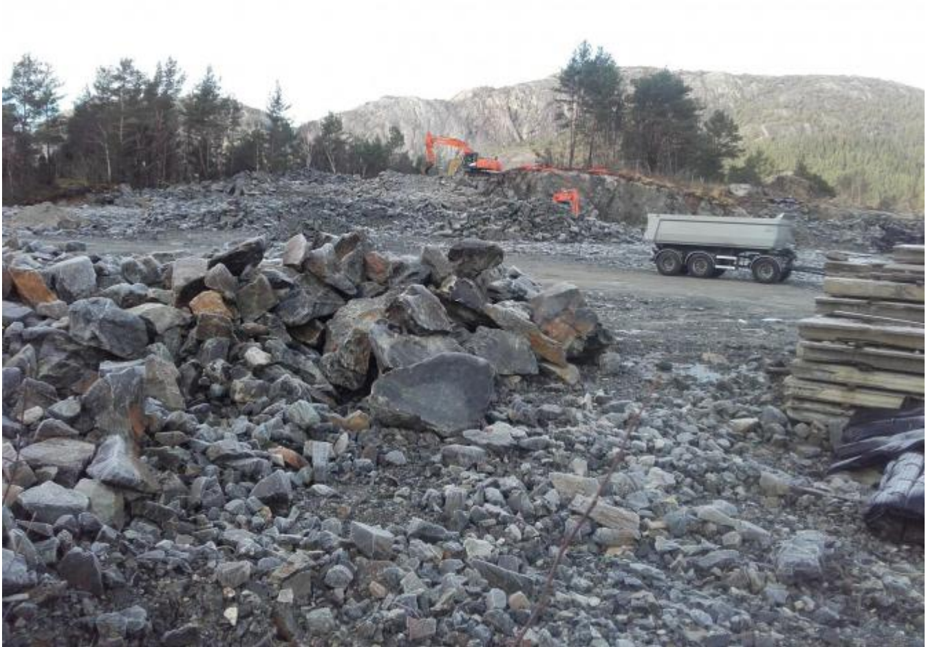
Arbeidet med fjellsprenning og knusing av massar pågår med full styrke.
