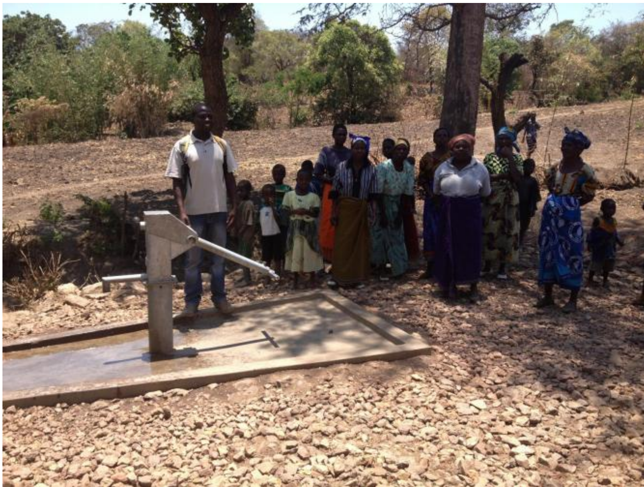
Medan dette er tipp topp. Reint grunnvatn med sikring mot nedrenning av overvatn. (Foto: Ragnhild Tennebekk Bjørke)
