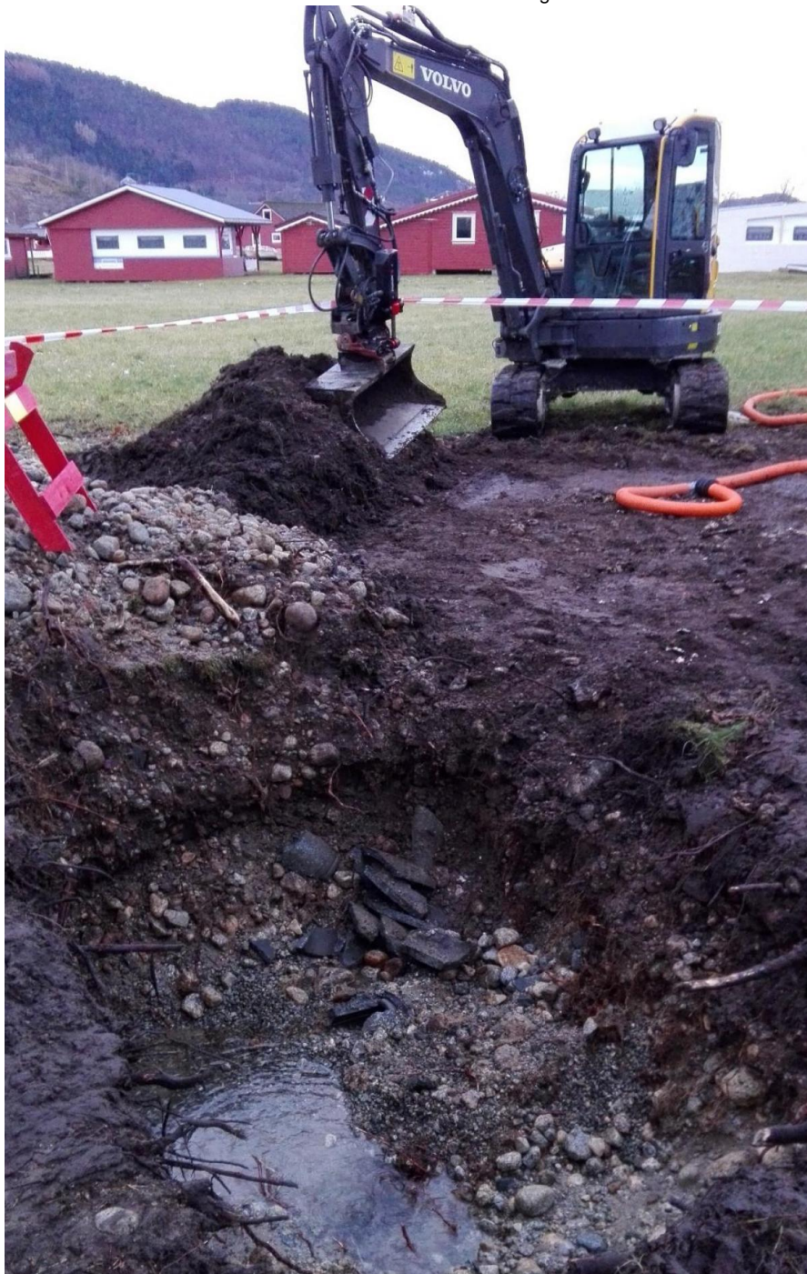
Lekkasjen er nedi denne hola, og det renn betydelege mengder vatn ut i grunnen.
