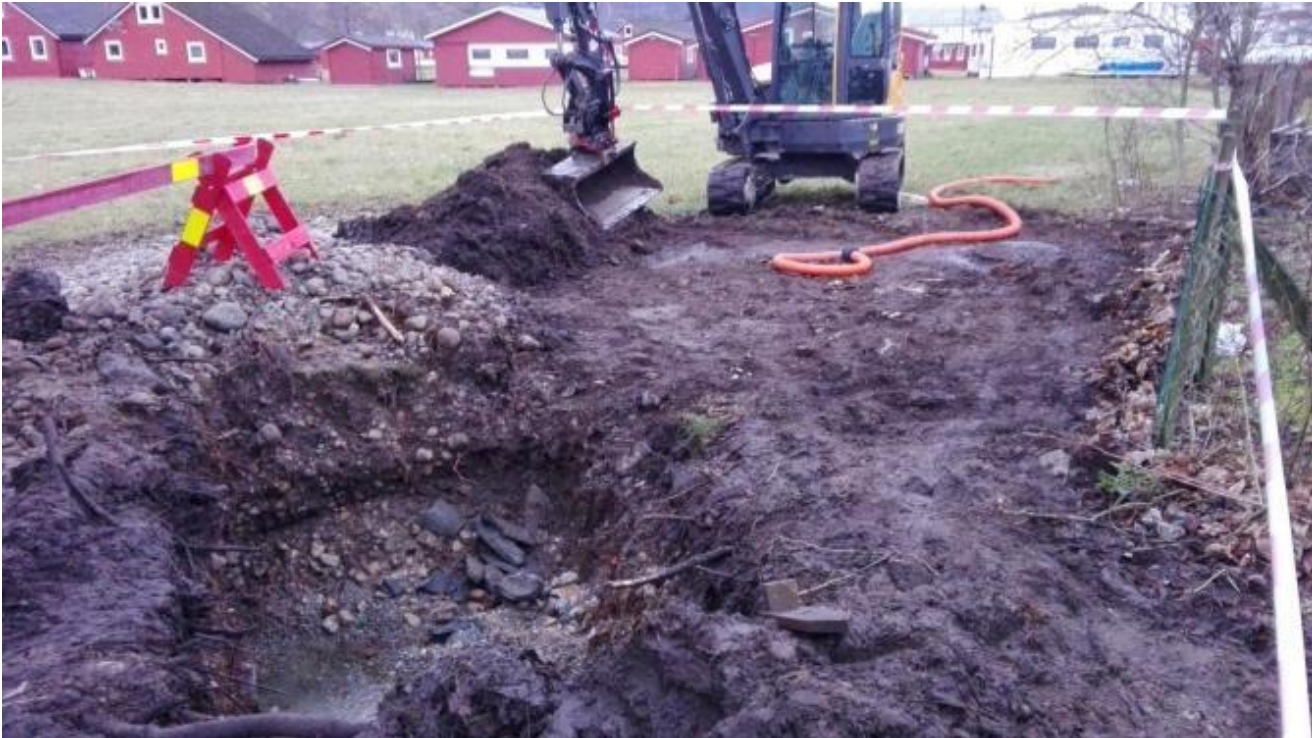
Vatnet må stengjast for å få reparert denne vasslekasjen.
