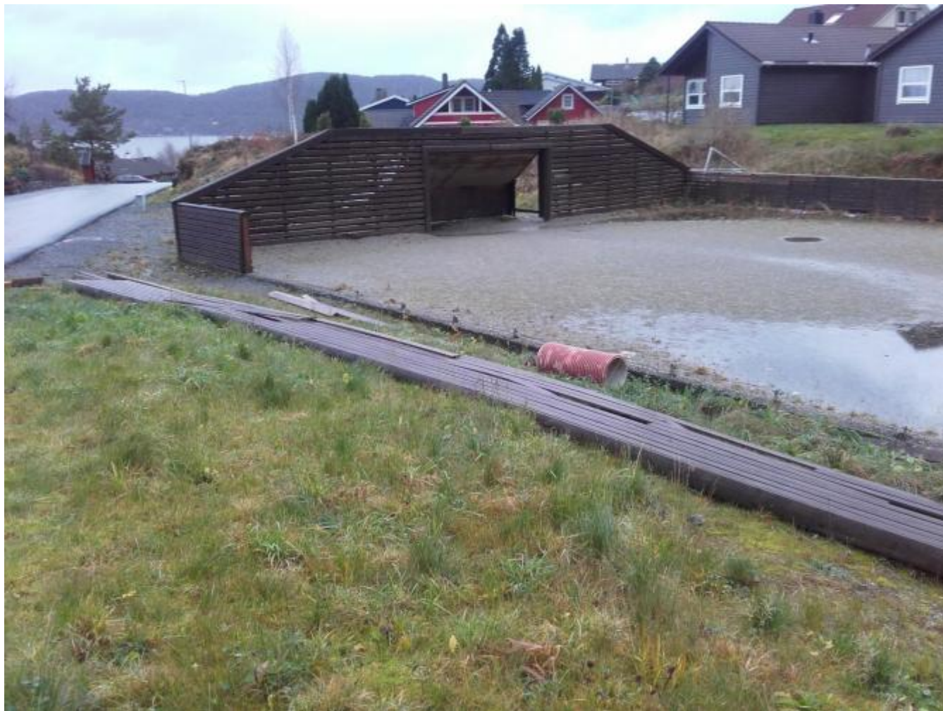
Den eine langveggen på ballbingen i Korsneset er riven frå fundamentet og lagt flat.
