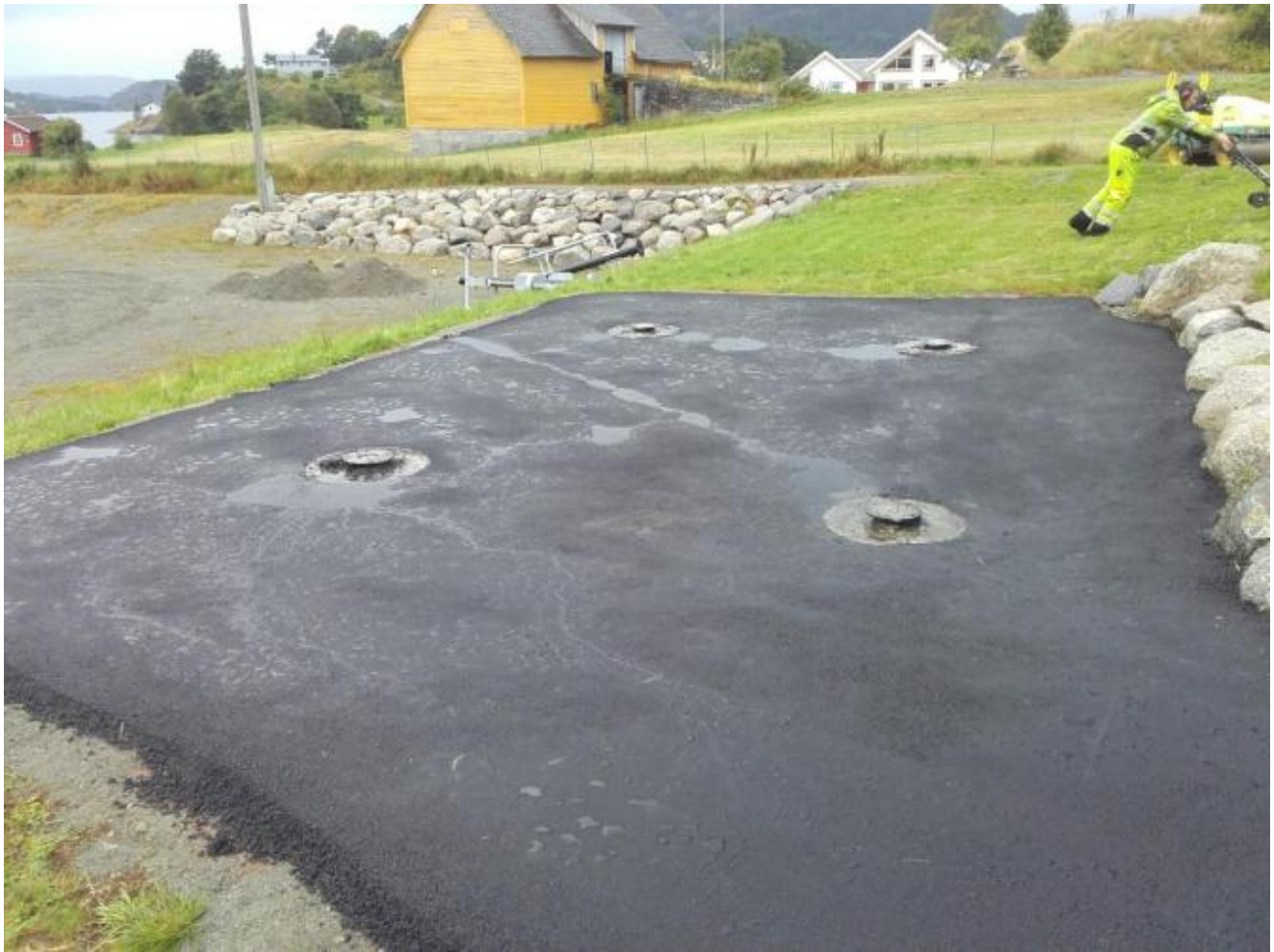
Aktivitetsflata er asfaltert og treningsapparata kan monterast.
