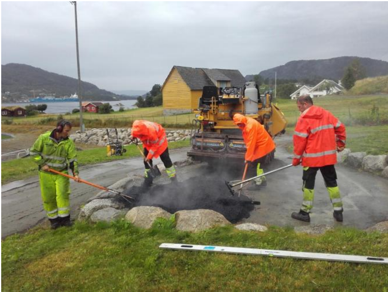
Kvinnherad Asfalt legg ut asfalt på alle aktivitetsflatene og gangvegane i område.
