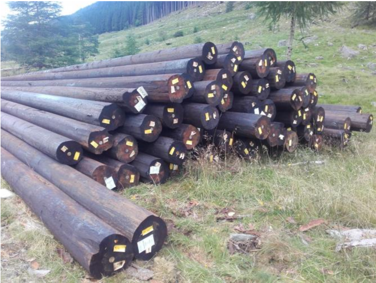
Nokre av stolpane til oppgraderingsarbeidet med 66 kW linja ligg lagra ved Vonheim.
