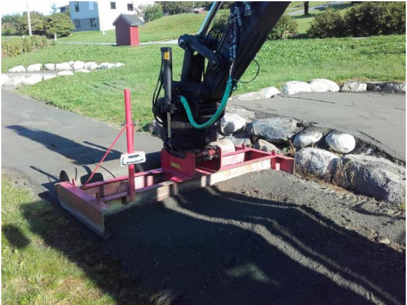
Stian Haugland frå Haugland Maskin planerer og pakkar grusen med å bruka ein avrettingsbjelke, som han styrer i alle retningar.
