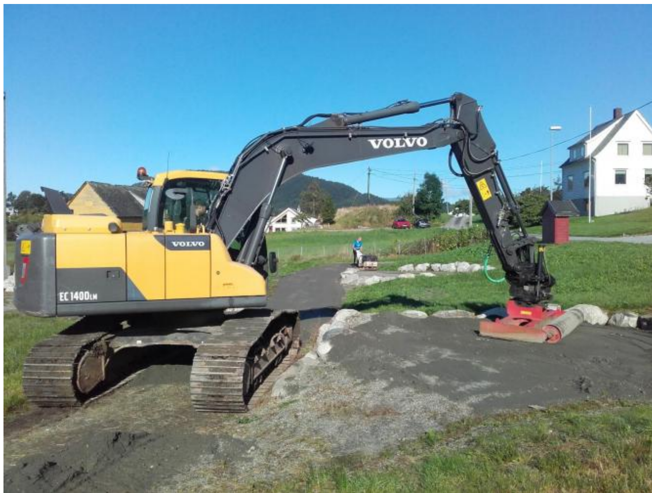
Stiane og aktivitetsflatene vert klargjort for asfaltering i veka som kjem.
