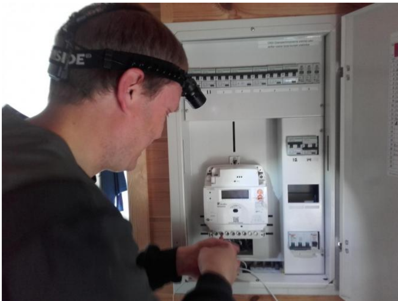
Bjørn Kenneth Andreassen innleigd frå Kvinnherad Elektro monterer den fyrste automatiske straummålaren i Uskedalen, i hytta til Tore Langballe på Skorpo.
