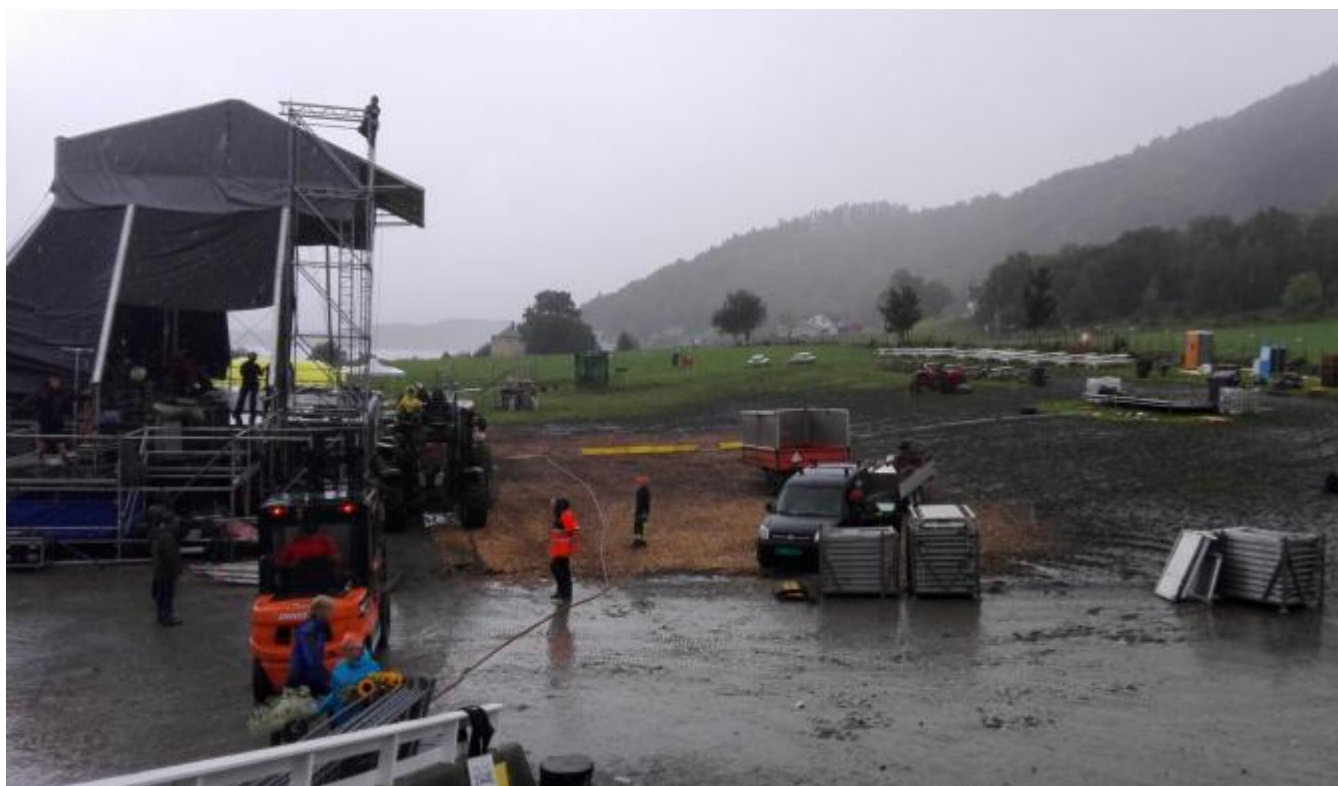
Kl.12 var dugnadsfolk i arbeid med alt frå nedrigging av scene, telt og elektrisk anlegg til bortkøyring av høy og høyballar.
