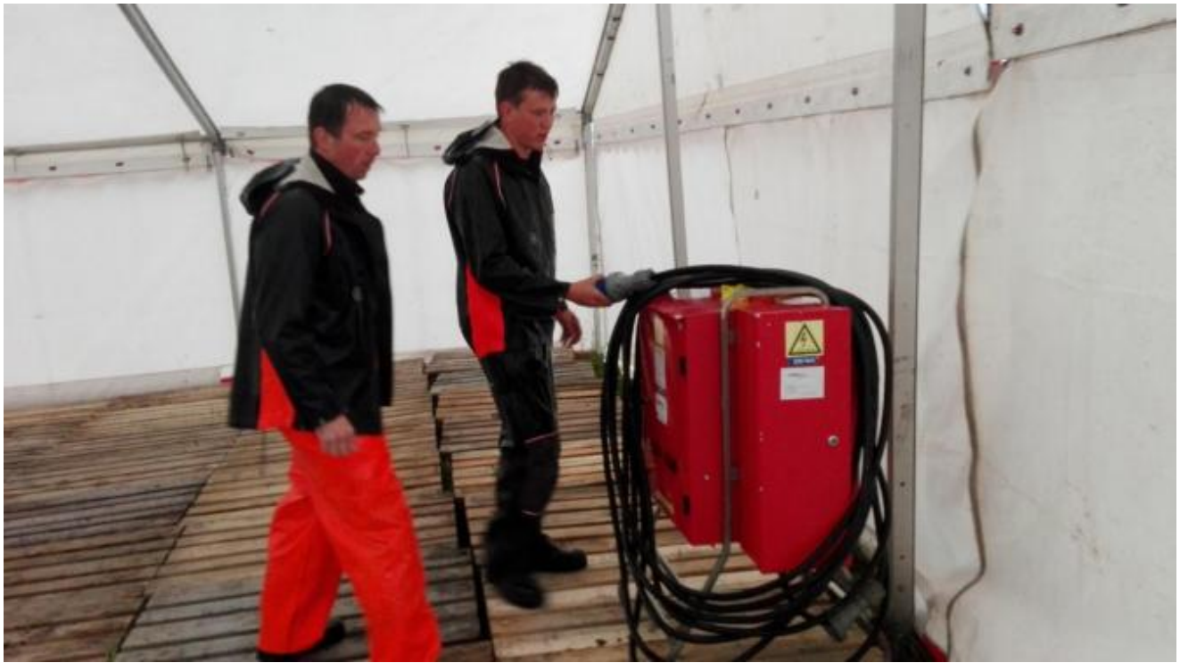
Kl.17.30: Elektrikarane Helge Sunde og Svein Ove Kjerpeseth i arbeid
