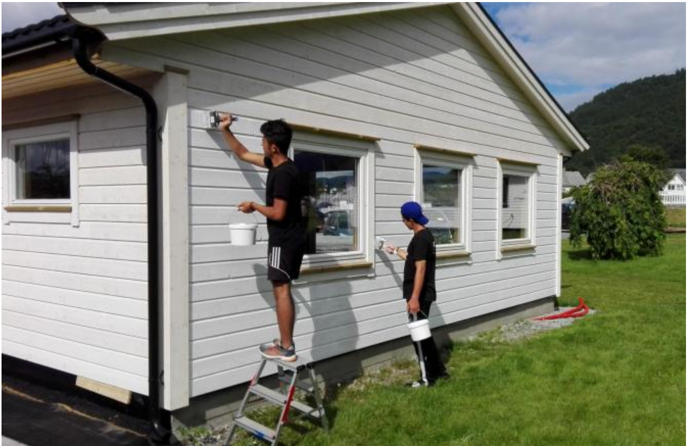
Abdul Ahad og Didar målar det nye huset i båthamna.
