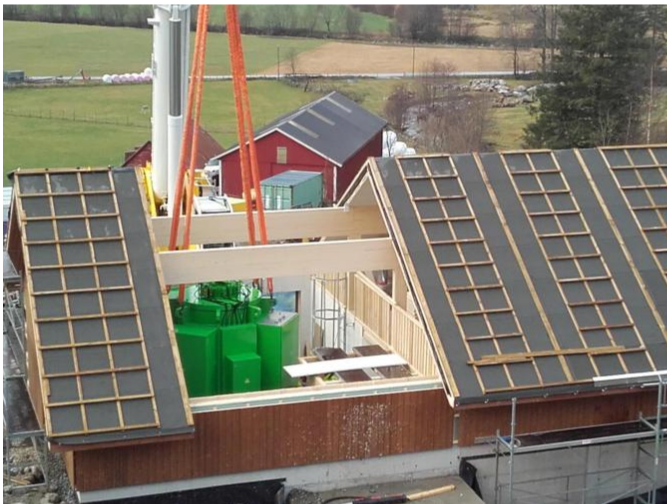
Aggregatet vert heist på plass i kraftstasjonen på Haugland.
