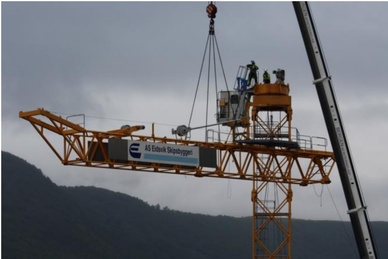
Kranen på Eidsvik vert demontert for service og skrifte av svingkrins. Bilete syner montørane på ein luftig arbeidsplass.
