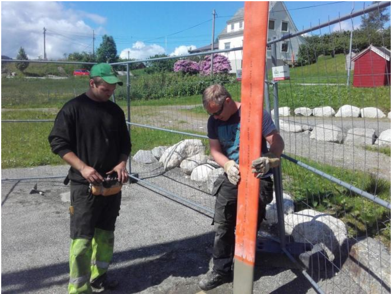
Jostein Hauso frå Uskedal helselag har kalrgjort med forskaling og montering av ein indre kjerne for søyleskoa.
