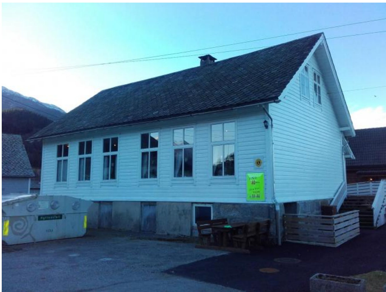
Det er løyvd kr. 70.000,- i kommunalt byggetilskot til Gamleskulen. Dermed kan arbeidet halda ram med ferdigstilling av kjellaren.
