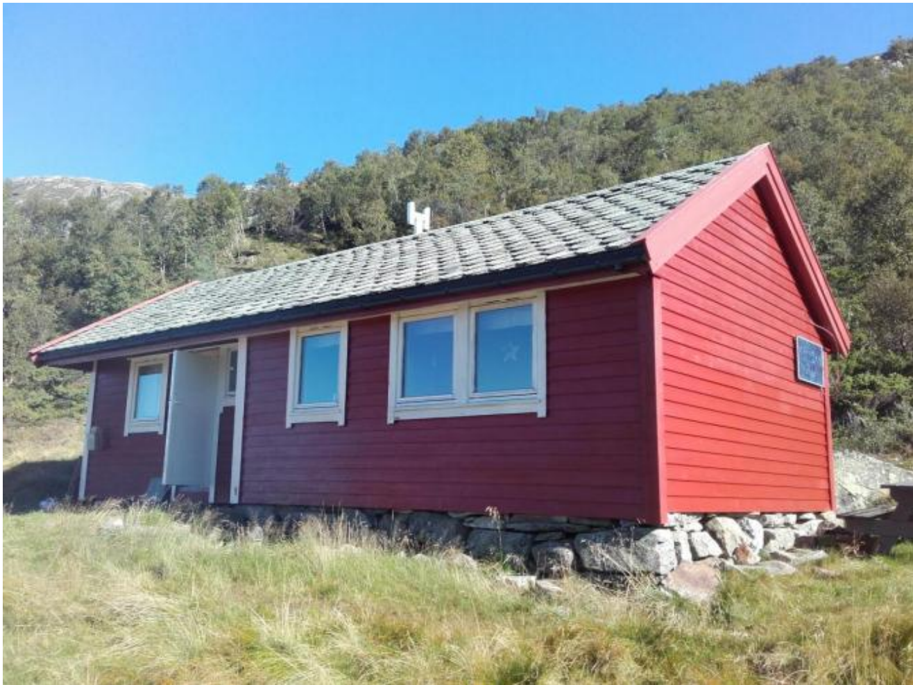
Lagshytta Fjelly slik vi ser henne i dag nymåla og renovert.
