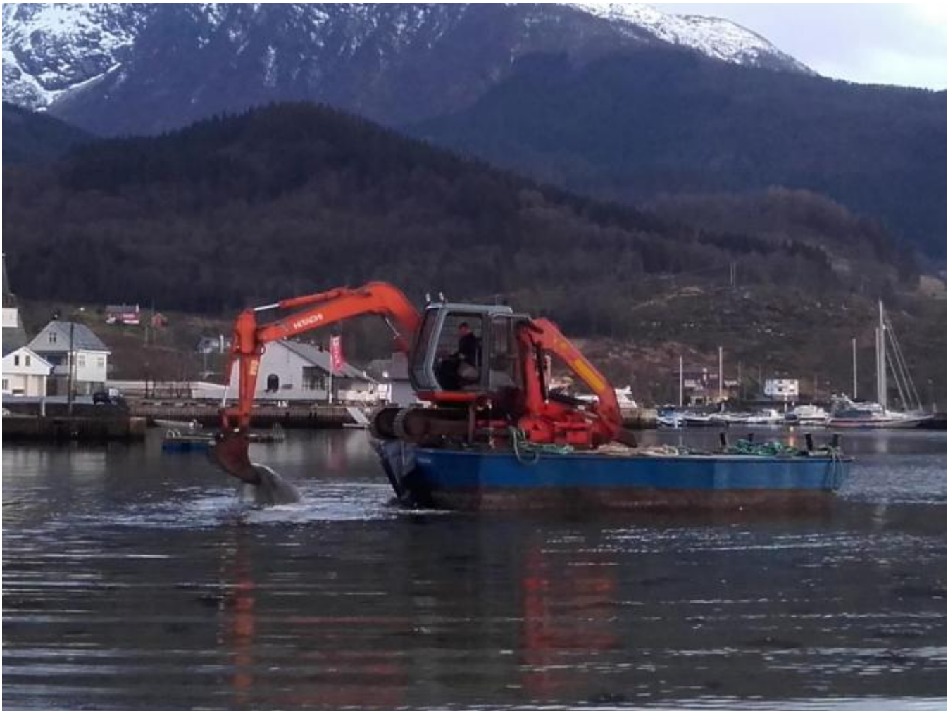
Arbeidet med nedgraving av overløpsledningen starta i kveld på fjæra sjø.
