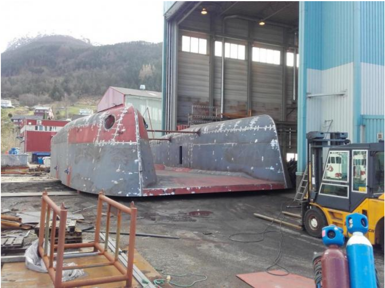
Neste skrog vert trilla ut av byggehallen for sning.
