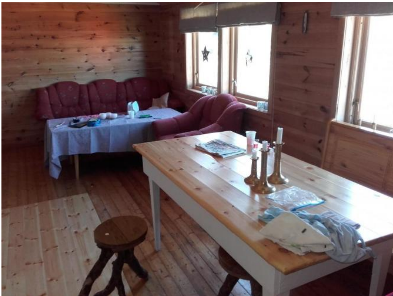
Taket i stova er senka, golv og treverk er behandla.
