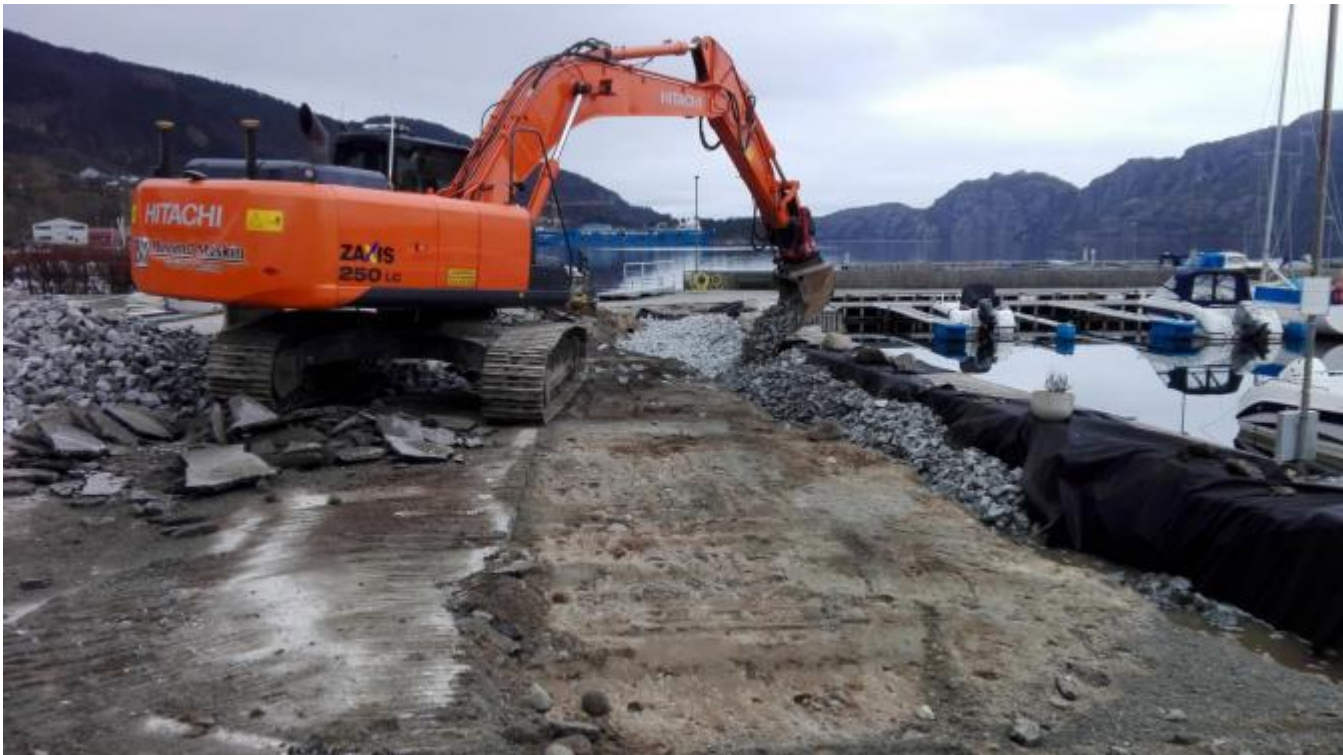
Det føregår no eit større utbetningsarbeid i båthamna.
