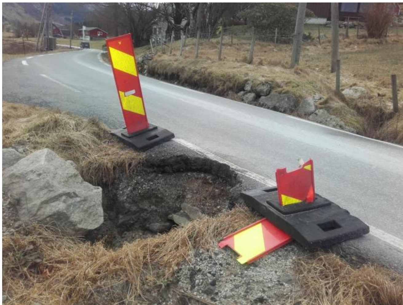
Vegkanten er rasa saman i ei grøft på Øvre Fet,- eit kritisk punkt særleg for gåande og dei som sykklar.
