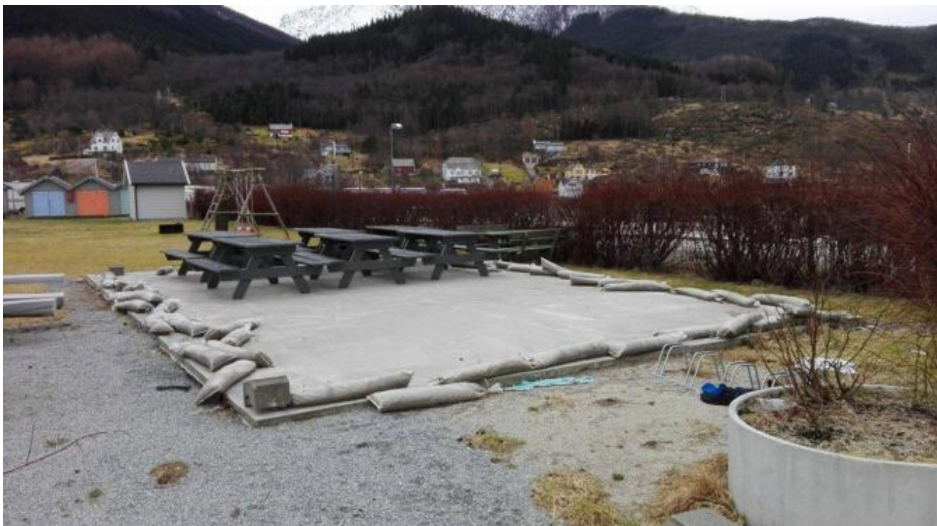
På denne betongplata skal nybygget koma.
