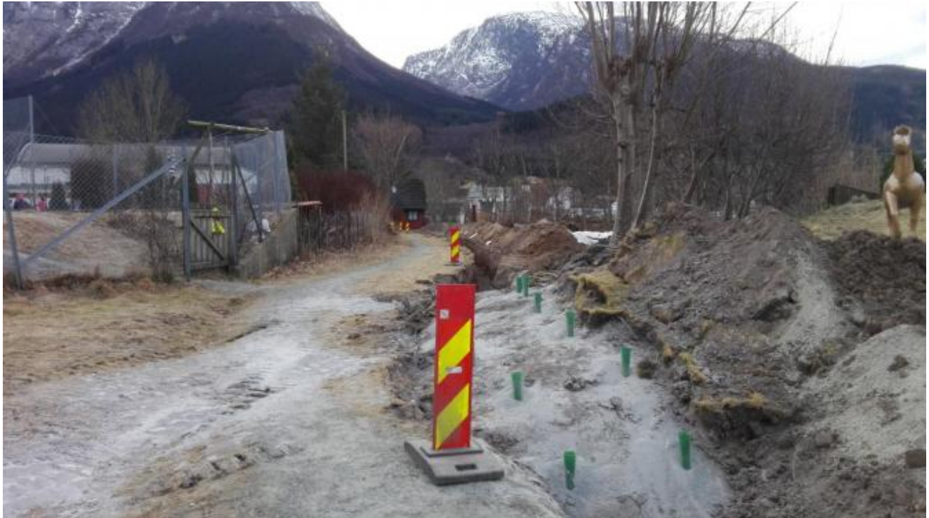
Kabelen vert lagt i jord frå stolpen nedanfor skulen.
