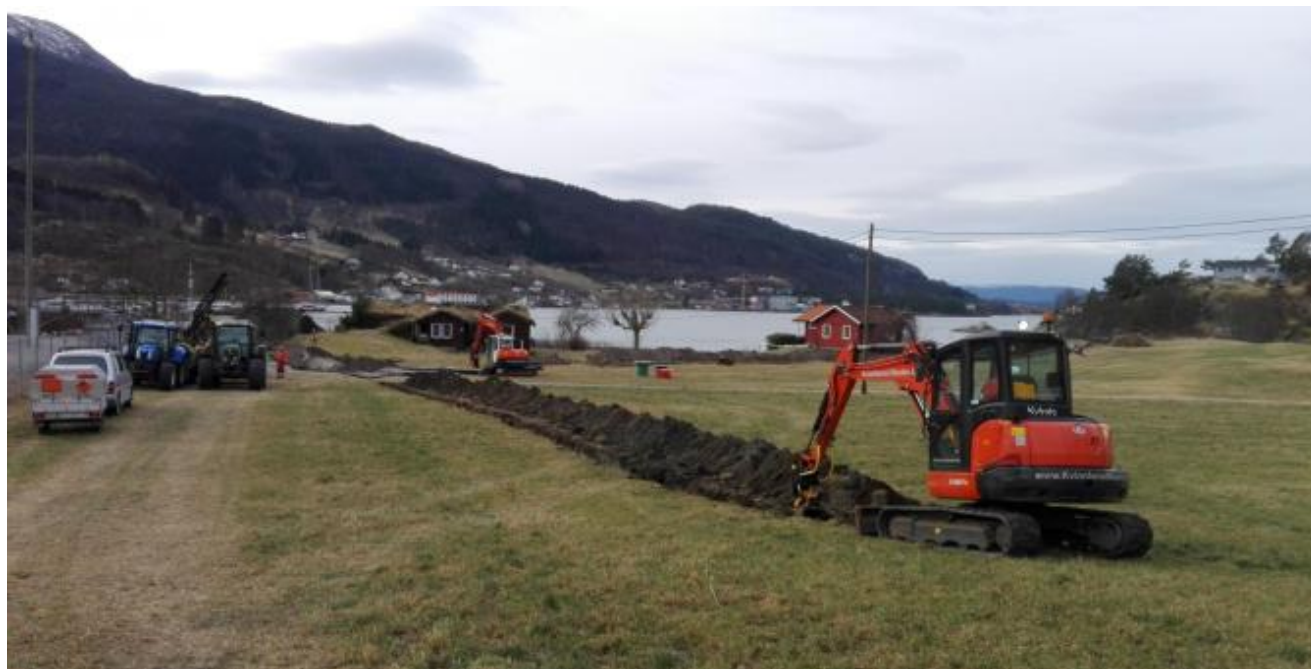
Straumkabelen på Neset skal no i grøft.
