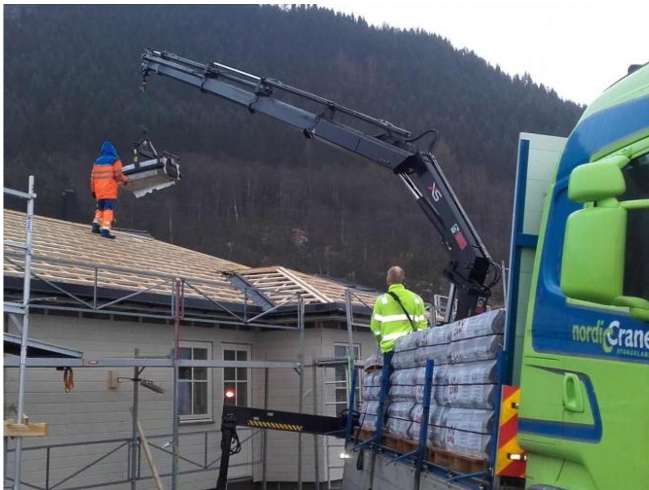
Alt er klar for byggesteg 2 i Ospelunden.
