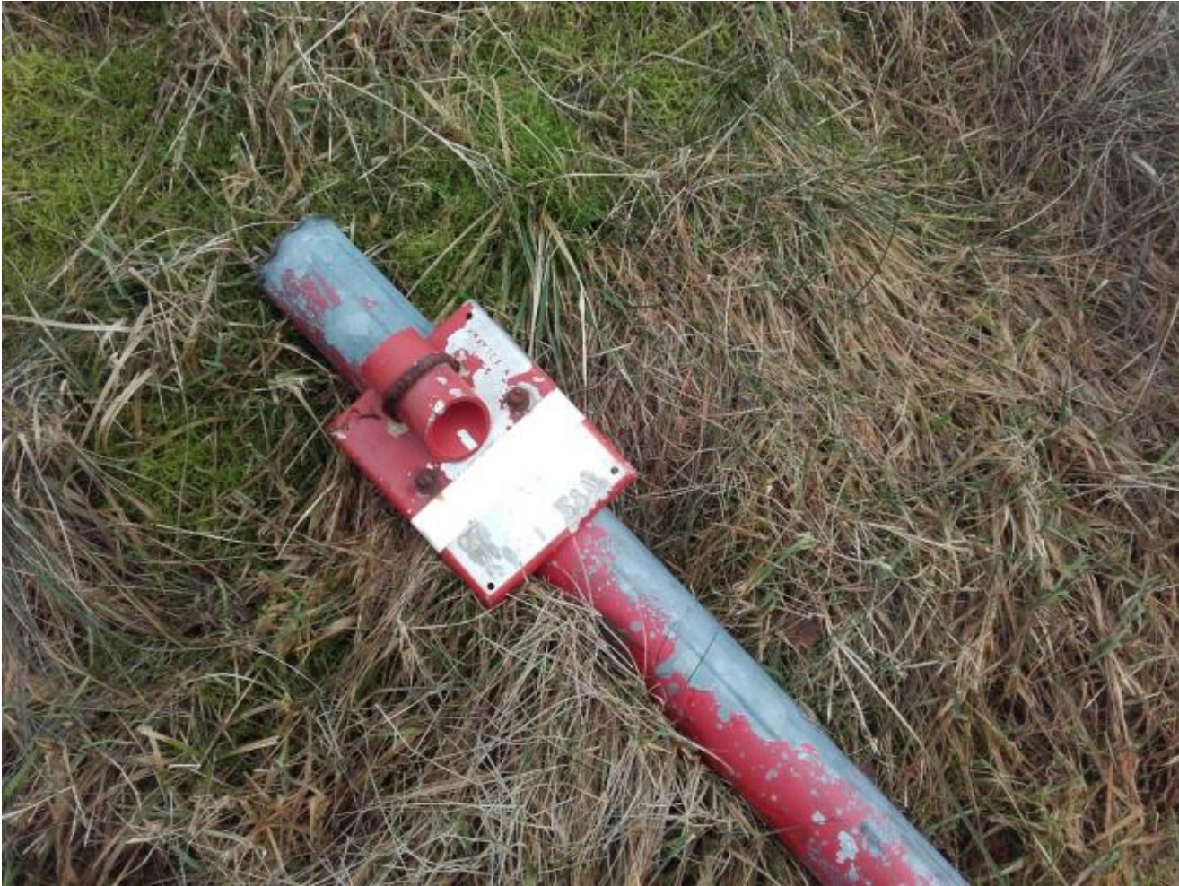
Skilt med raud topp markerer brannkum.
