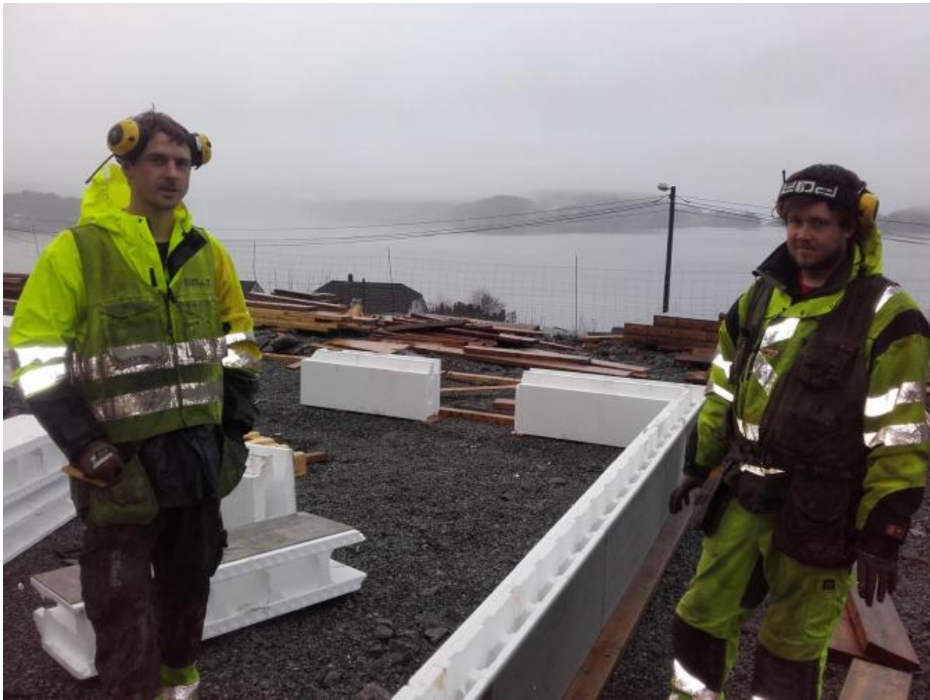
Ole Martin Trondsen og Jarand Soma frå firma Ermland Forskaling står for forskaling- og betongarbeidet på 3- mannsbustaden i Ospelunden byggefelt.
