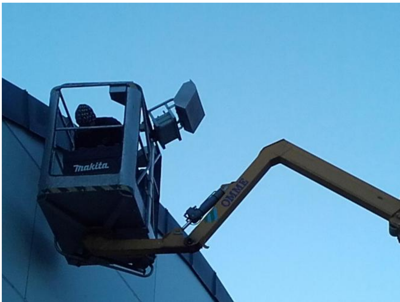
Hoem Blikkmontering utbetra skaden på Aktivitetshuset i dag.
