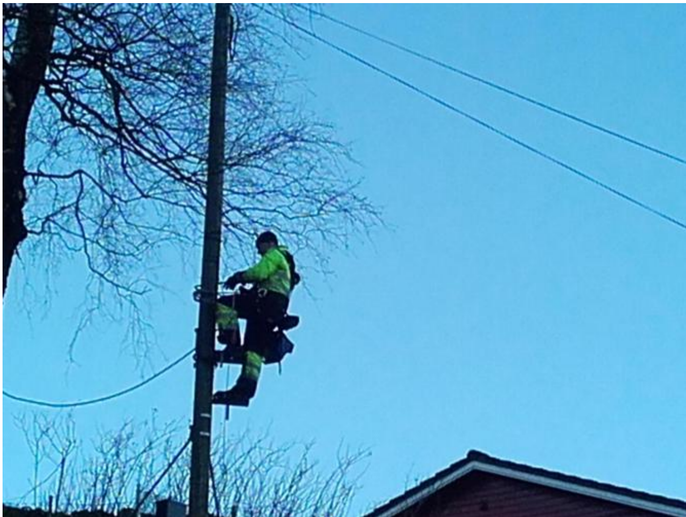
Skaden på Nedre Fet vert utbetra av Kvinnherad Energi
