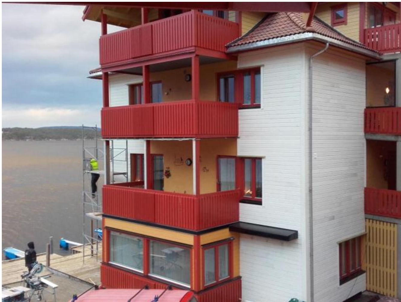
Deler av drevsida på Telegrafbygget vert kledd inn.
