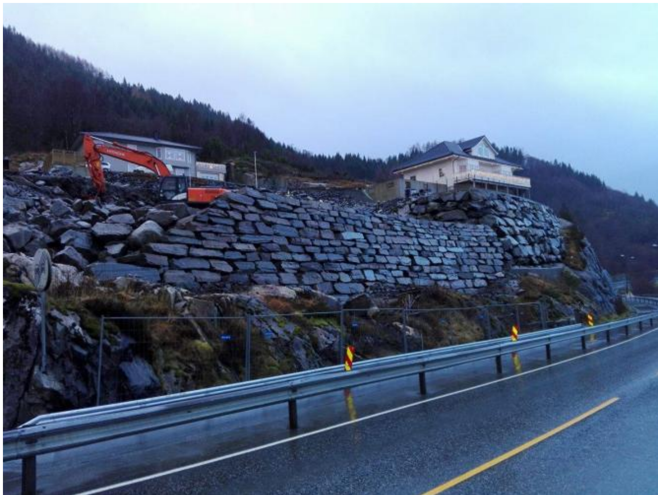
Brødr. Musland er i ferd med å avslutta arbeidet med ein flott mur i Ospelunden.
