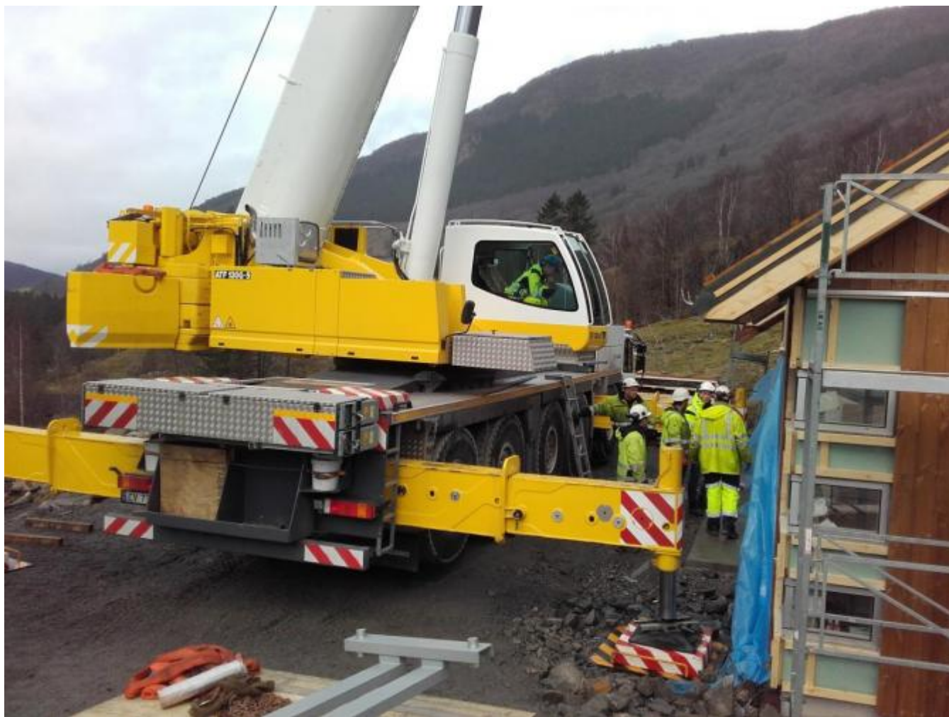
HARDING sin krane vart brukt for å ta eit løft på 30 tonn.
