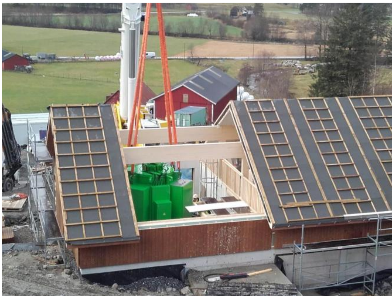
Generatoren på 30 tonn vert sett på plass i kraftstasjonen.
