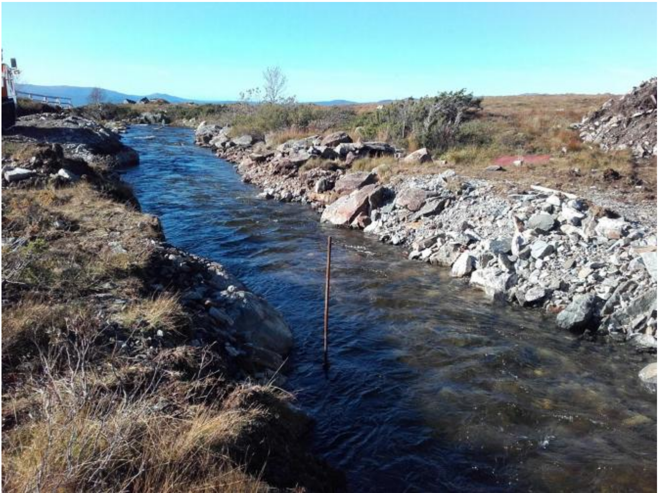
Elveløpet frå Mannsvatn mot den nye dammen 400 meter nede i lia.
