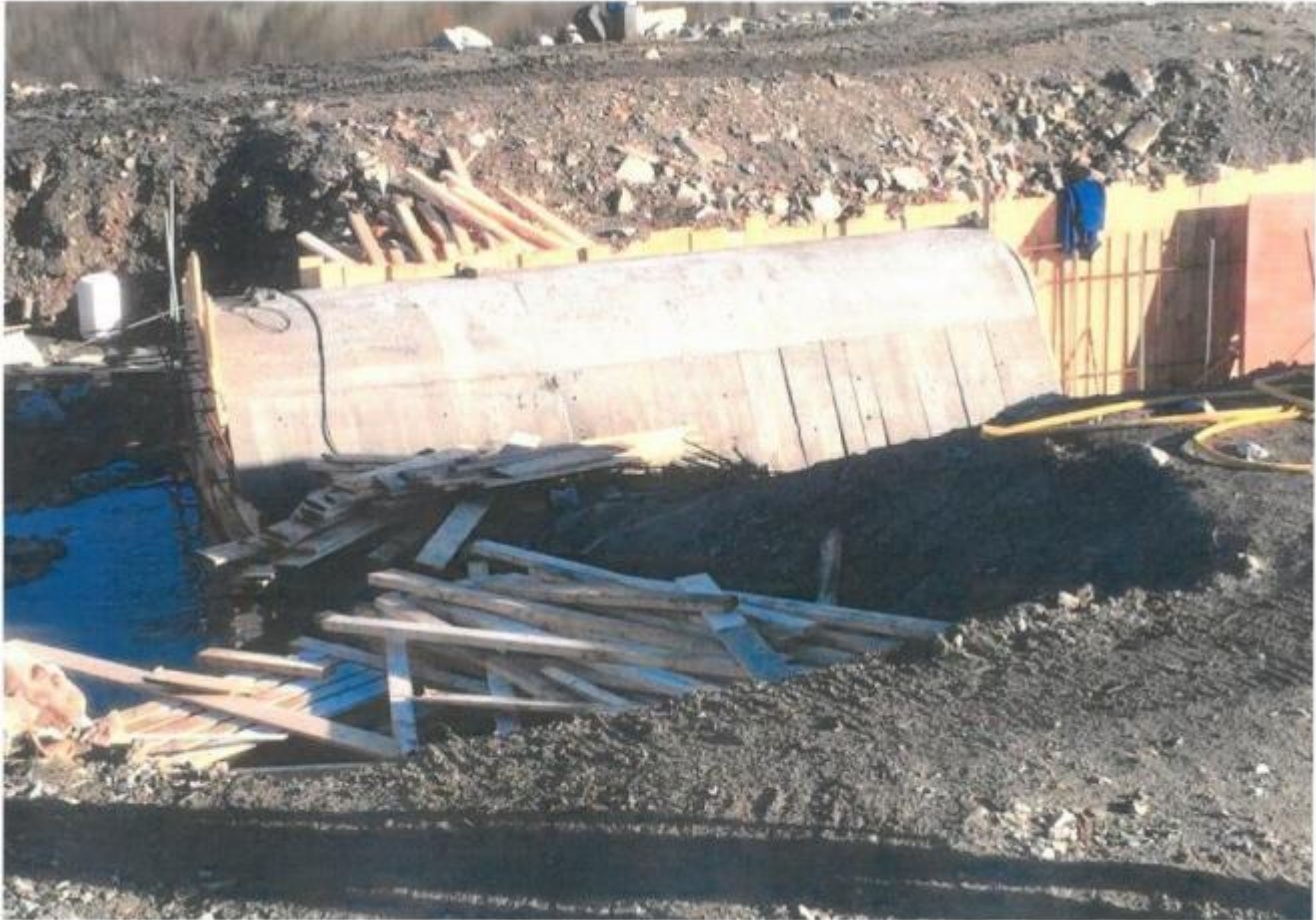
Støping av seksjonar til dam ved Mannsvatnet
