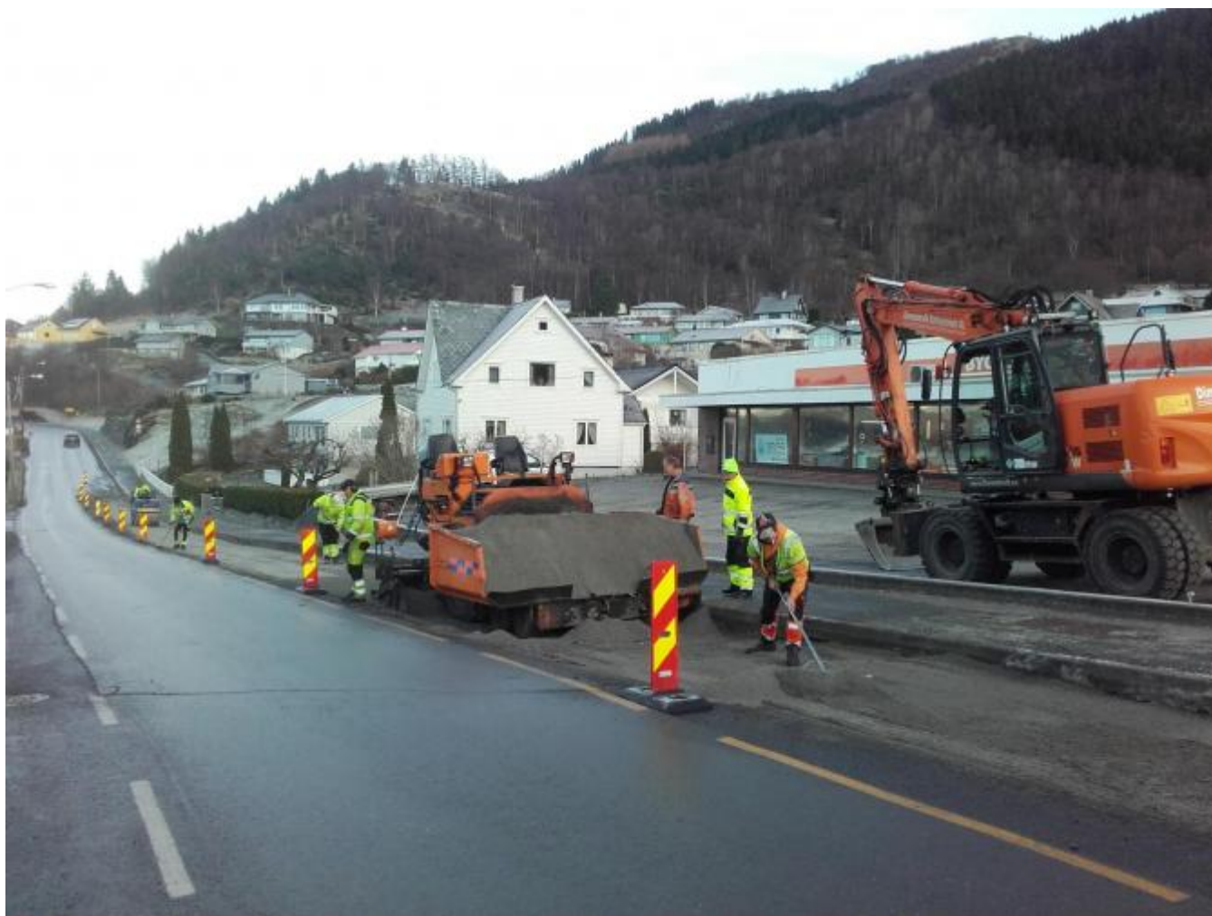
Klargjering til asfalteringa tok til mens det enno var dagslys.
