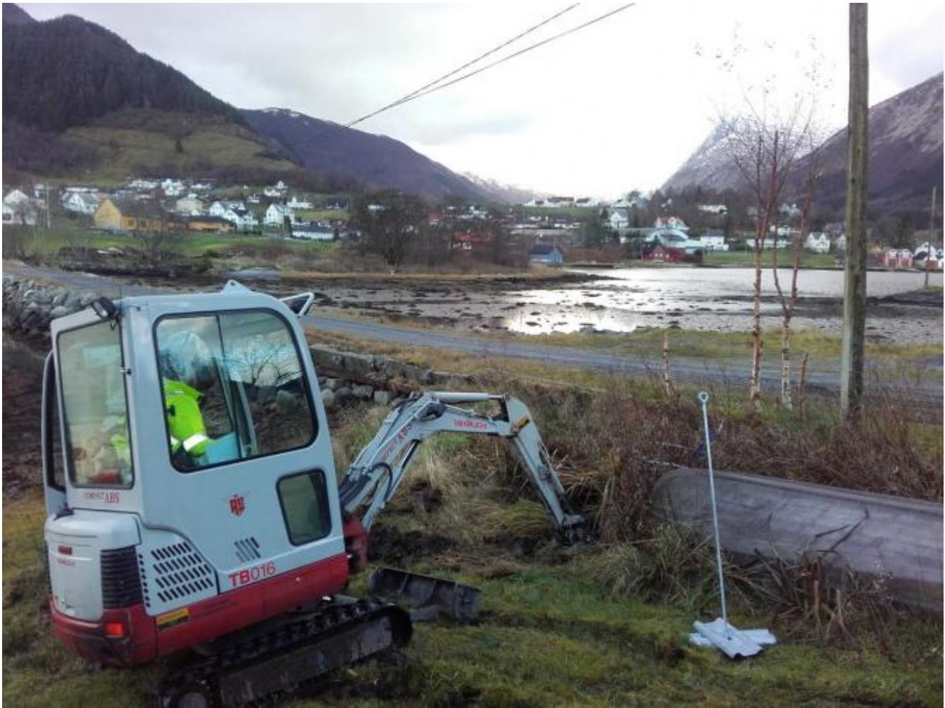
Dårlige stolpar vert bytte ut med nye. Bilete er frå arbeidet på Holmen.
