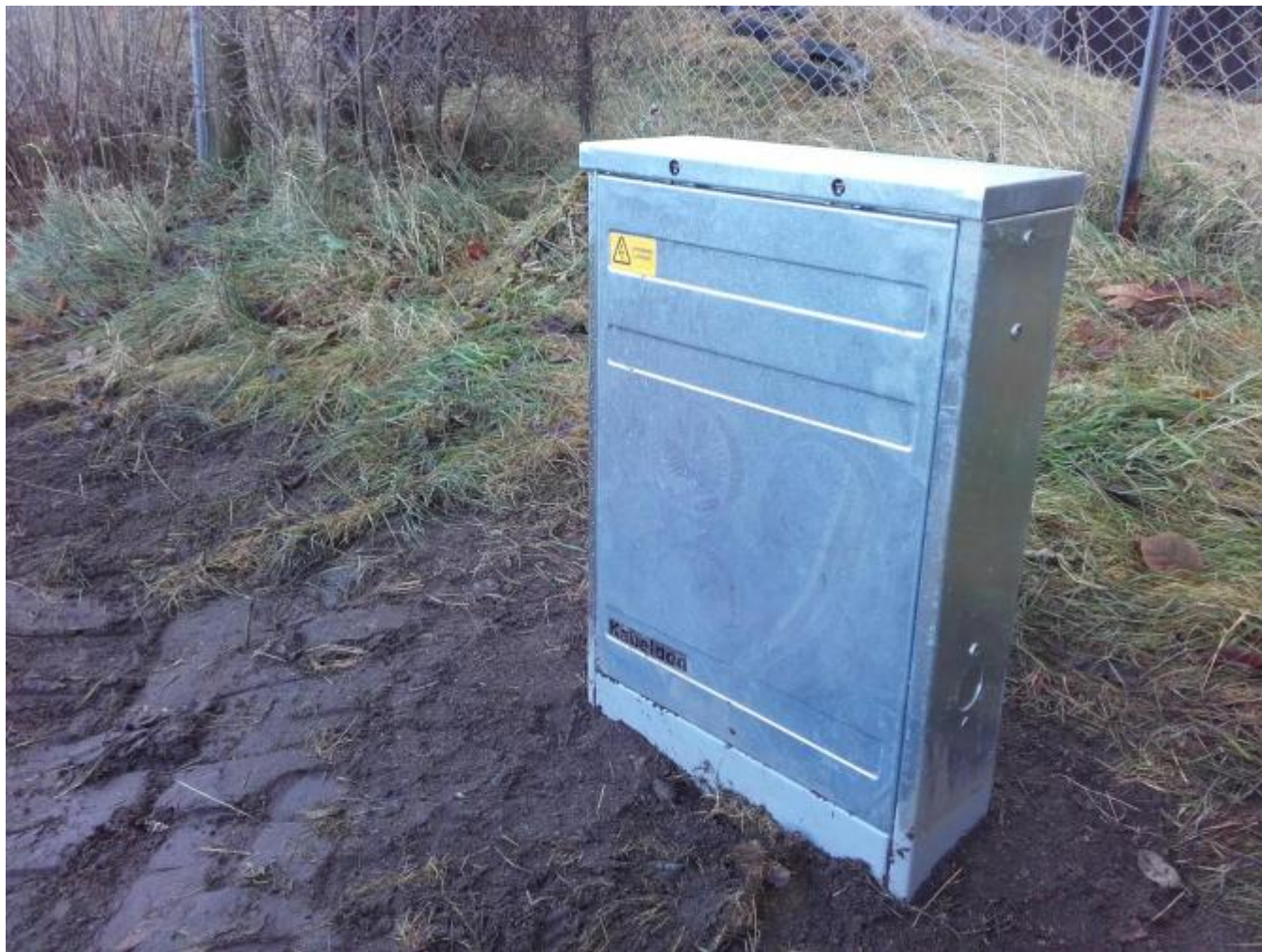
Straumskåpet er montert ved pumpestasjonen og skulen.
