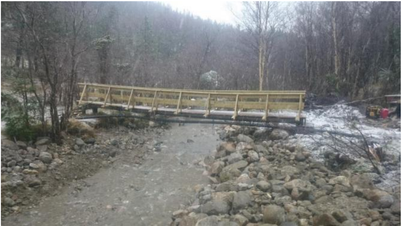
Den nye brua ved Flåtene. Brua er heva på Feet-sida for å gje betre klaring ved stor vassføring(Foto: Johannes Feet)
