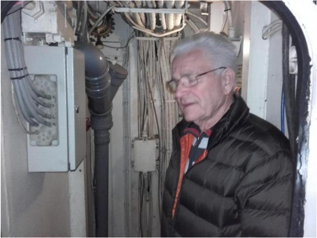
Kåre Hauge ved nedgangen til maskinrommet.
