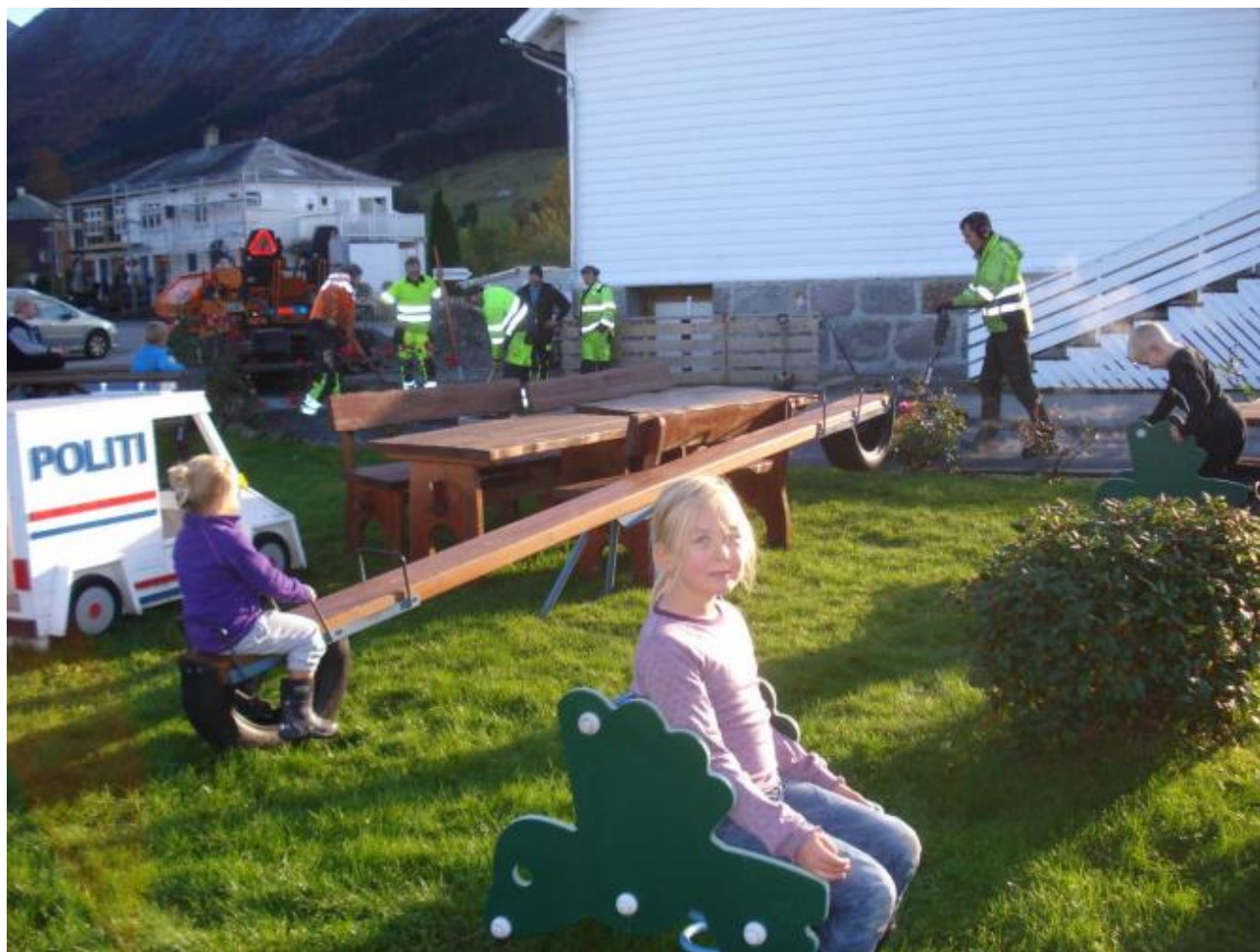
I dag kjem det asfaltdekke ved Gamleskulen.
