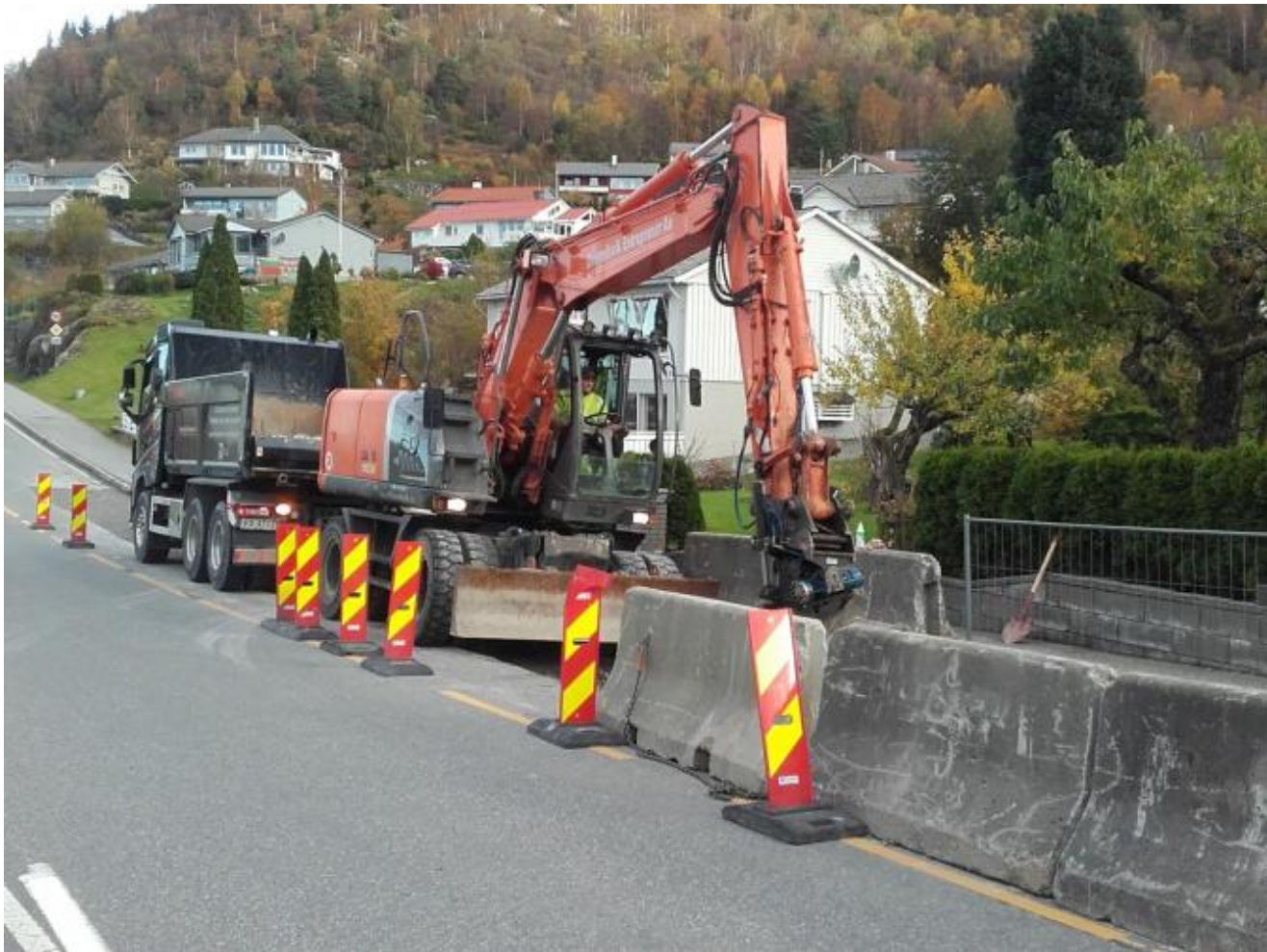
Arbeidet med grøfter på Fylkesvegen i sentrum vart meir omfattande enn planlagt.
